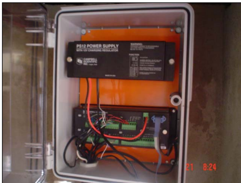
Figura 3.4 - Datalogger modelo CR10X
