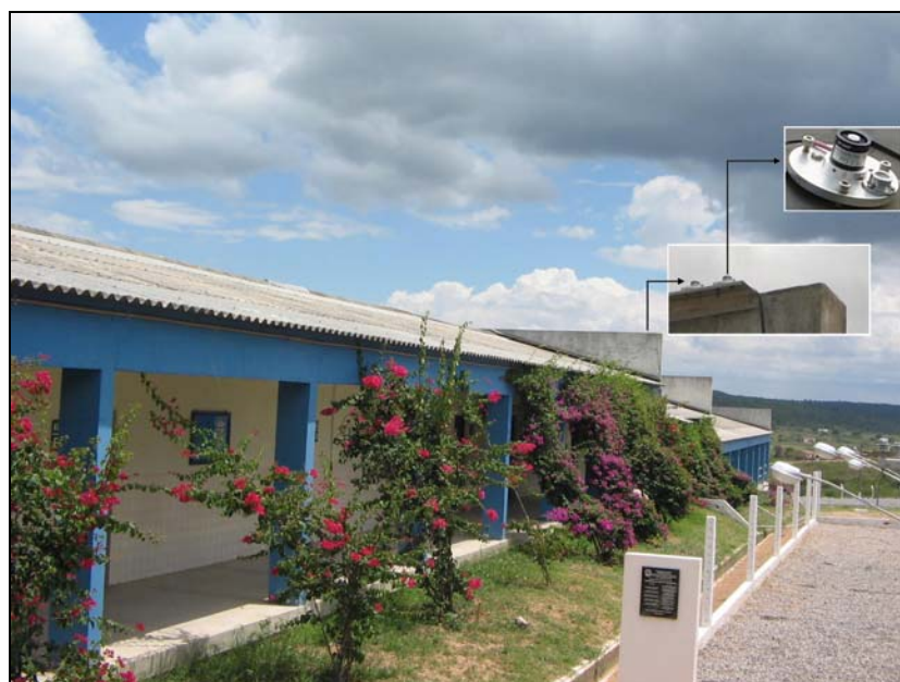
Figura 3.3 - Visão detalhada do piranômetro modelo LI-200SA para medição da irradiação solar, instalado no telhado do CEFET-Pesqueira
