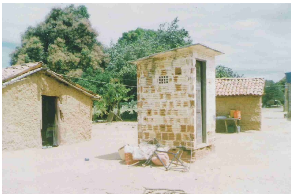
Foto 2: Nas casas de taipa, os banheiros são construídos à parte e são utilizados por mais de uma família.
