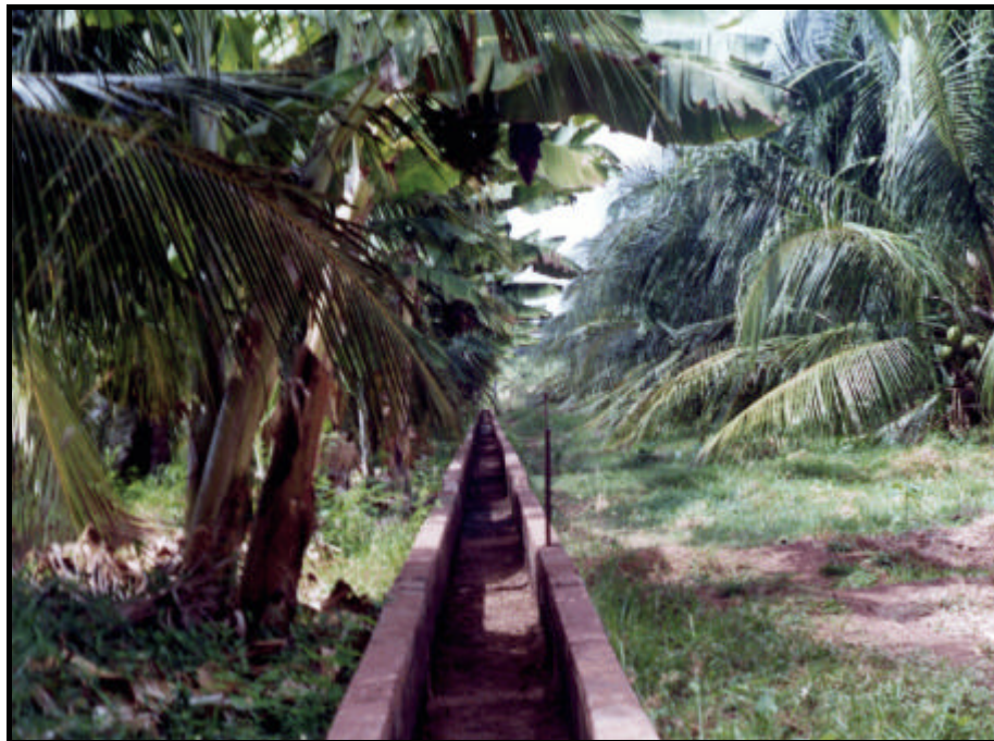
Canal secundário que corta os lotes
