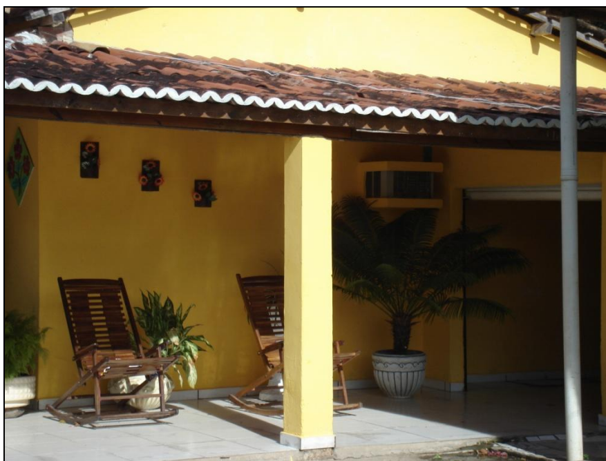
Fotografia 7 – Detalhe da imagem: ar-condicionado na residência do cooperado - Aldeia Botafogo
