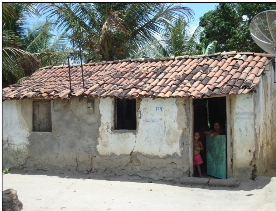
Fotografia 5 – Condições de moradia da população do entorno - Aldeia Botafogo
