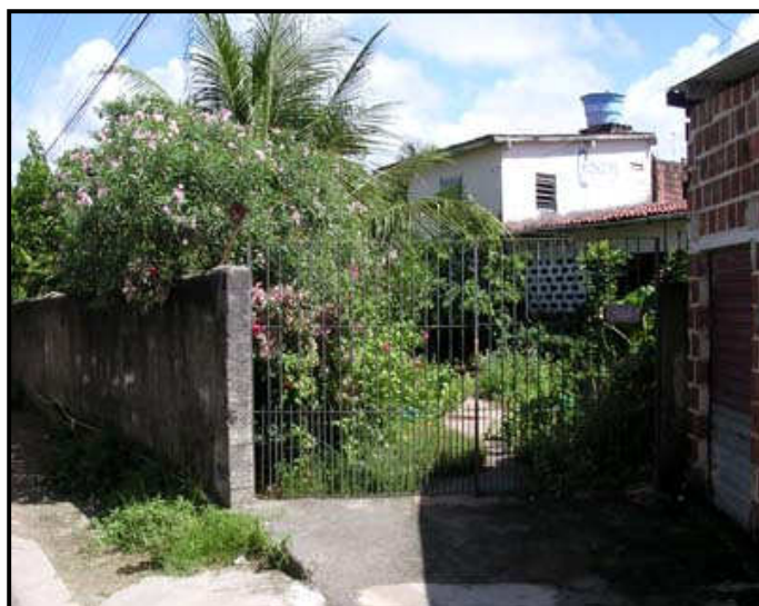
Figura 2 – Entrada do Centro de Saúde Alternativa de Muribeca (CESAM) em Jaboatão dos Guararapes, Pernambuco.
