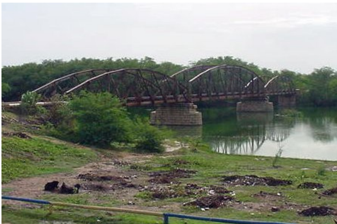
FOTO 2- Ponte ferroviária localizada no do Alto da Conceição sobre o rio Mossoró
