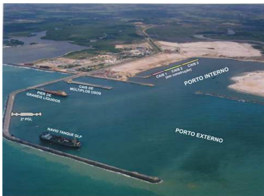
Figura 2. Vista aérea do CIPS (Gov. PE, 2001).
