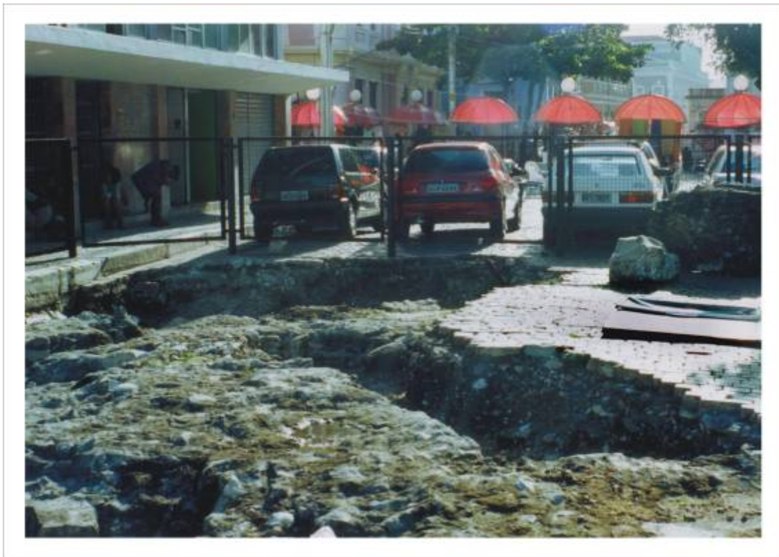
A área da escavação – início dos trabalhos em 2004
