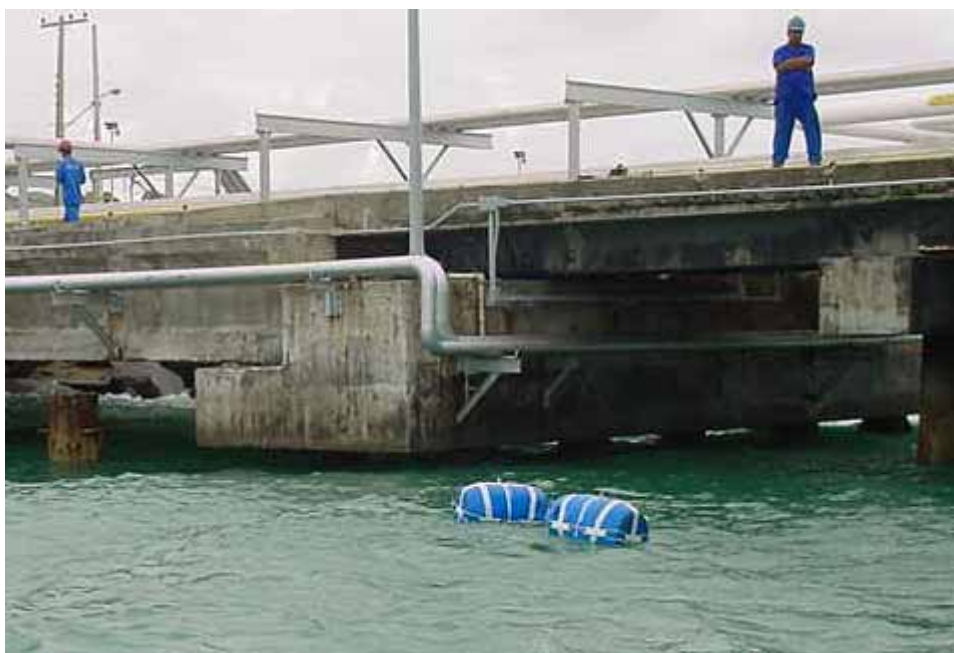
Figura 06: Píer de graneis líquidos (PGL 1) e flutuadores que sustentaram o cavalete contendo as placas metálicas para estudo da bioincrustação no Porto Externo de Suape.
