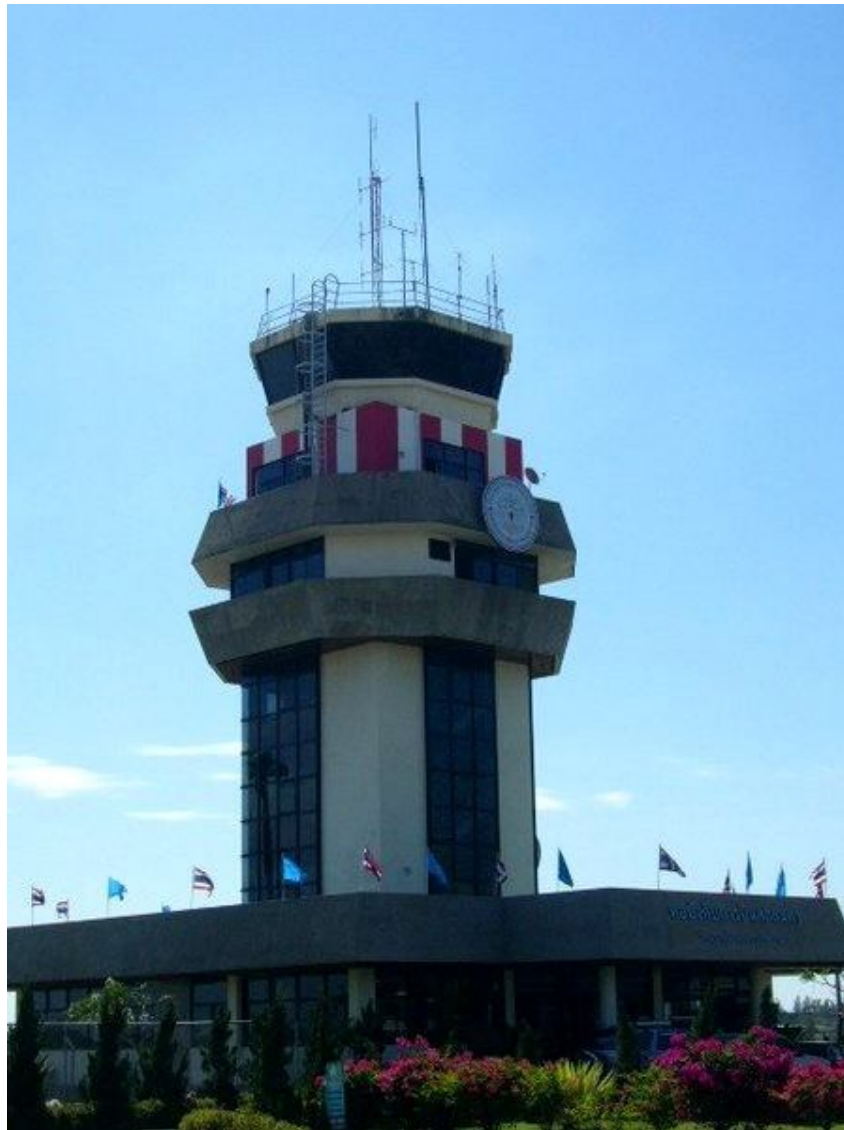
Figura 1. Visão externa de uma Torre de Controle. Órgão responsável pelos tráfegos em situações de pouso e decolagem e ainda pela circulação de pessoas e veículos na área de manobra, como as pistas e os caminhos de circulação. Numa divisão vertical, a torre de controle tem jurisdição sob os tráfegos que voam até 2000 pés de altitude.
