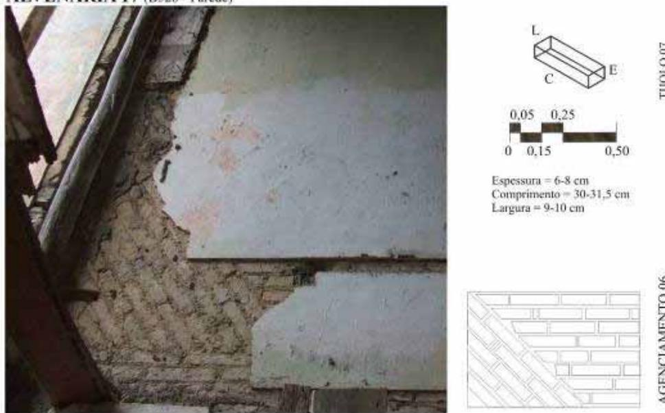
Figura 0100. Ficha de identificação da Alvenaria 17. Observar que essa alvenaria obedece a organização horizontal e diagonal dos materiais construtivos e que as linhas de continuidade são pouco rígidas. Fonte: Figura pela autora.
