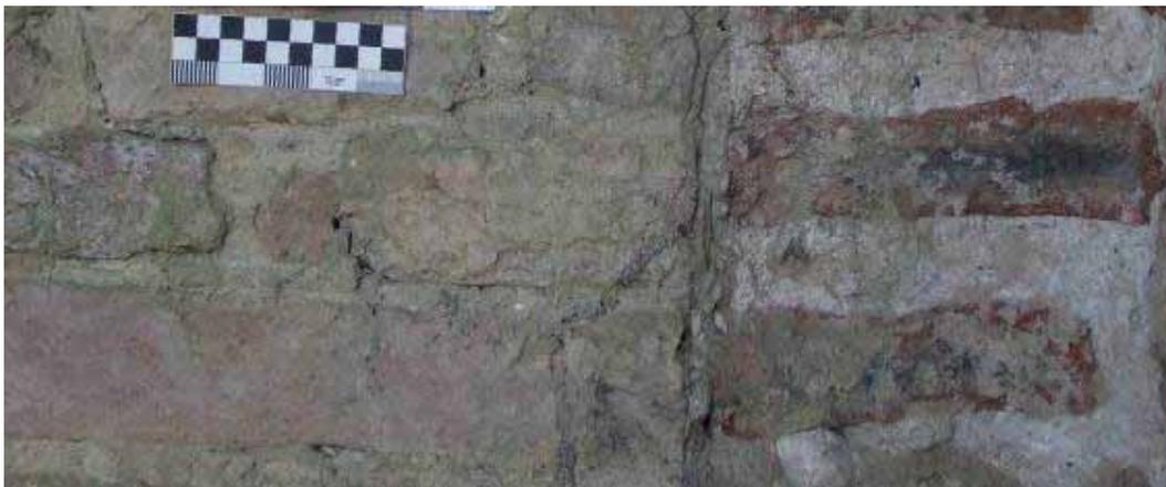
Foto 02. Exemplo de dois tipos de tijolos considerando a coloração da pasta a partir da superfície. Observar que os tijolos da direita, por estarem seccionados, permitem a visualização do interior enegrecido, mas é na superfície que se pode verificar a coloração da pasta. Fonte: Foto pela autora.
