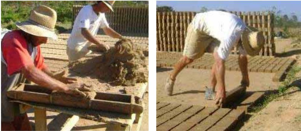
Foto 04. Exemplo de molde de madeira para preparação de tijolos cerâmicos maciços e do procedimento de retirar os tijolos conformados do molde. Esse molde permite que três unidades de tijolos sejam moldados ao mesmo tempo. Fonte: olariatudo em [http://www.griootzen.com/index.php?base\\_principal=base&id\\_base=8](http://www.griootzen.com/index.php?base_principal=base&id_base=8).
