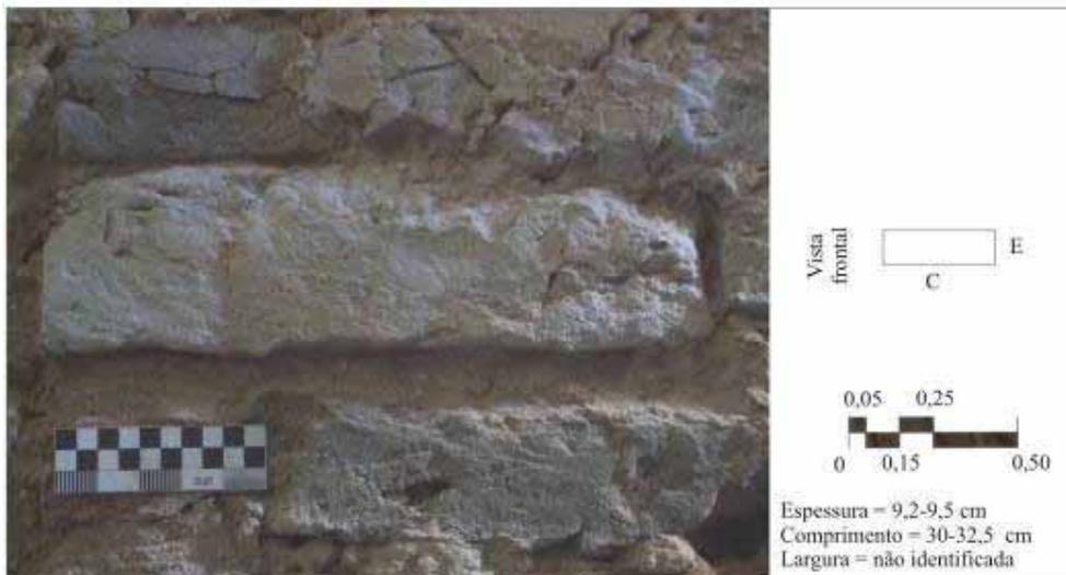
Figura 074. Ficha de identificação do Tijolo T9. Observa-se a cor/ composição de argila branca, o formato retangular irregular e a face fraturada e enrugada, com aresta viva. Fonte: Figura pela autora.
