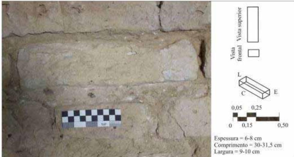
Figura 072. Ficha de identificação do Tijolo T7. Observa-se a cor/ composição de argila branca, rosa, cinza e café, o formato retangular irregular e a face fraturada e enrugada, sem aresta. Fonte: Figura pela autora.
