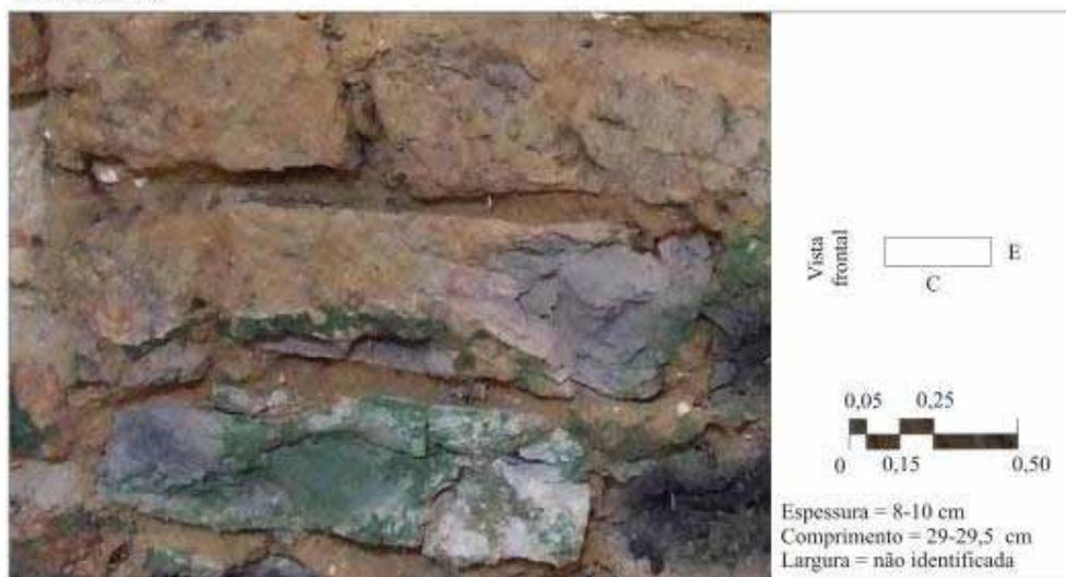
Figura 071. Ficha de identificação do Tijolo T06. Observa-se o formato retangular irregular e o mau estado de fragmentação da face. Fonte: Figura pela autora.
