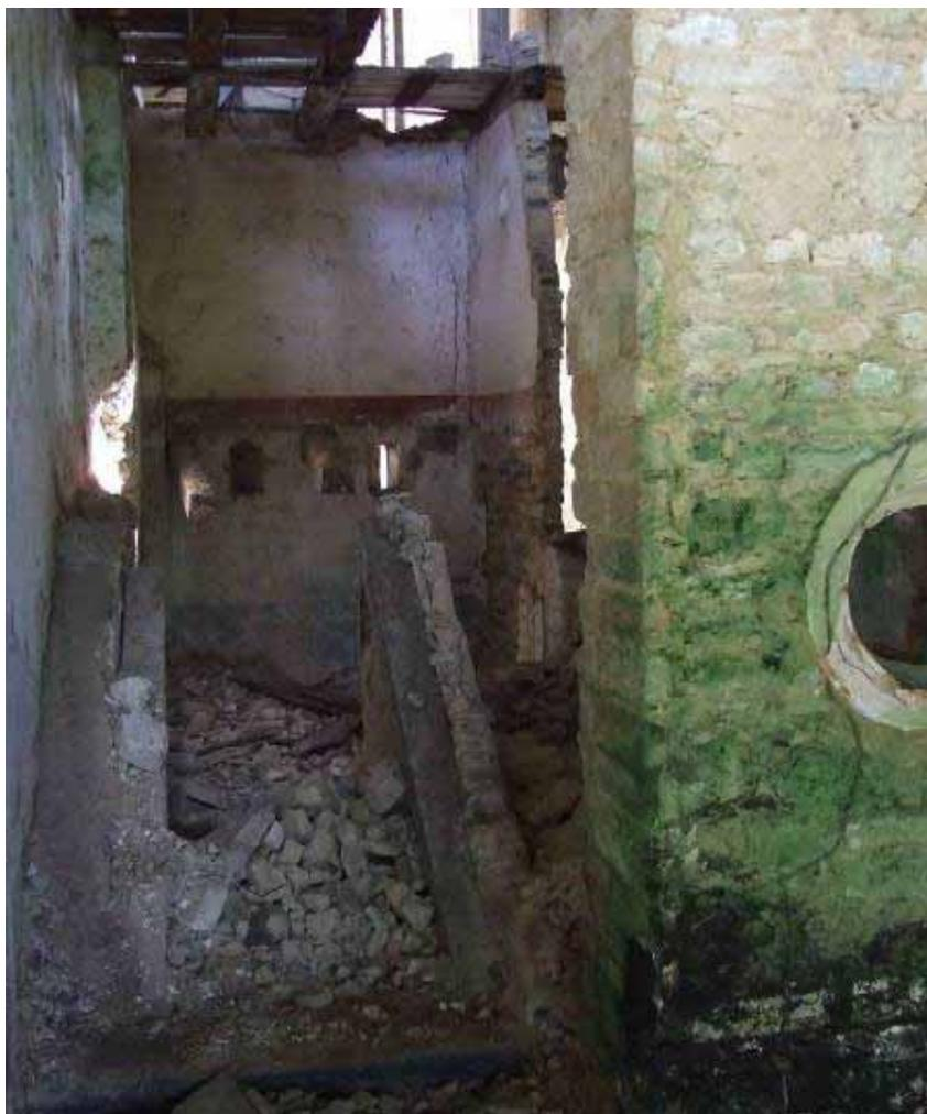
Foto 011. Vista dos restos da escada que dava acesso ao pavimento superior. Vêm-se as ruínas da estrutura de alvenaria que dava suporte à escada e os restos da estrutura de madeira do piso do pavimento superior. Fonte: Foto pela autora.
