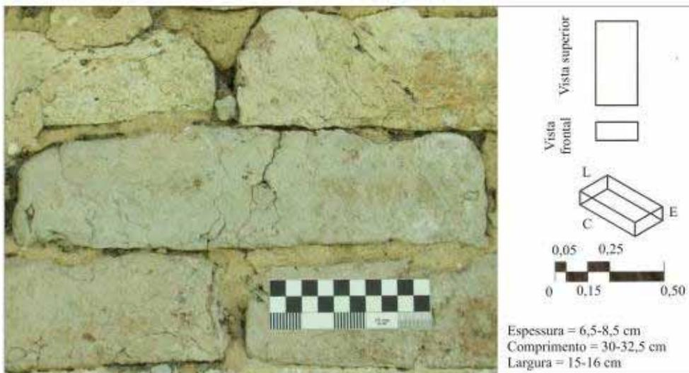
Figura 066. Ficha de identificação do Tijolo T01. Observa-se a cor/ composição de argila branca/cinza, o formato retangular irregular e uma face fraturada e enrugada, com aresta viva. Fonte: Figura pela autora.
