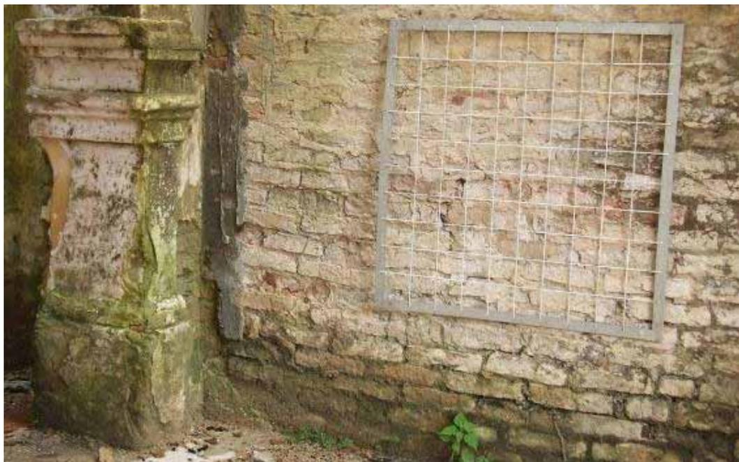
Foto 012. Grade metálica quadrada, de 1mx1m, com cordas verticais e horizontais a cada 10cm, que permite realizar o levantamento do agenciamento das alvenarias com precisão e velocidade, em campo ou no laboratório. Fonte: Foto pela autora.
