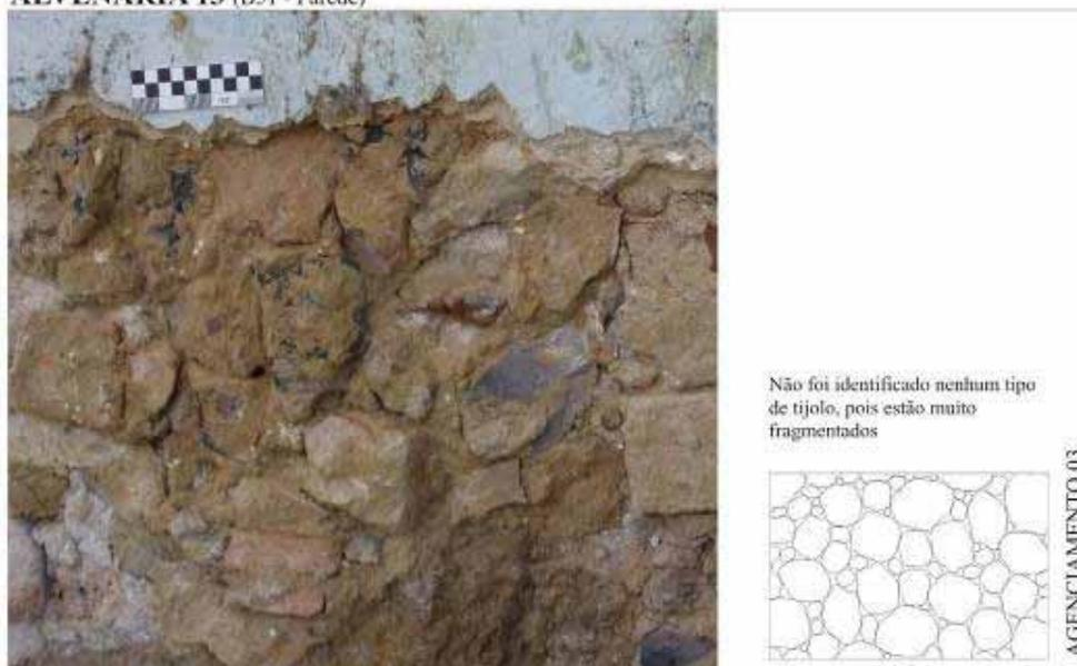
Figura 096. Ficha de identificação da Alvenaria 13. Observar que essa alvenaria não obedece a organização horizontal dos materiais construtivos, essa organização é tipo aglomerado. Fonte: Figura pela autora.
