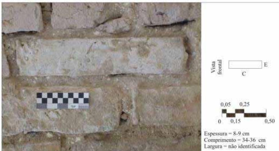
Figura 075. Ficha de identificação do Tijolo T10. Observa-se a cor/ composição de argila branca e cinza, o formato retangular regular e a face íntegra e enrugada, com aresta viva. Fonte: Figura pela autora.
