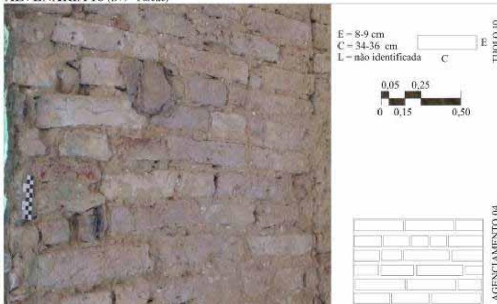
Figura 099. Ficha de identificação da Alvenaria 16. Observar que essa alvenaria obedece a organização horizontal dos materiais construtivos e que não há rigidez na organização pela ausência de linhas de continuidade entre tijolos de níveis diferentes. Fonte: Figura pela autora.
