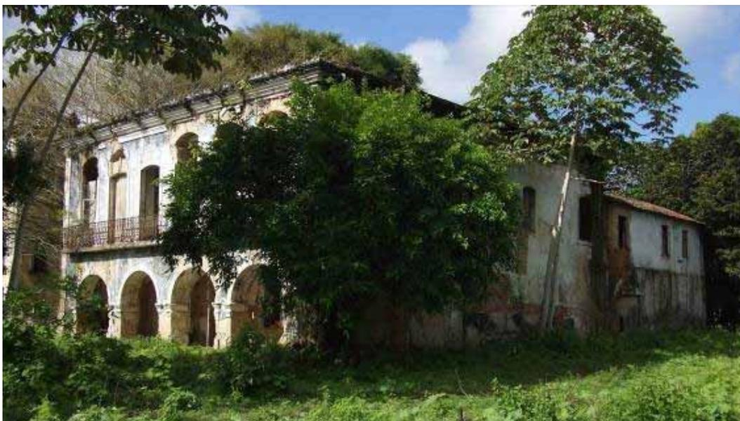
Foto 08. Vista da situação atual da casa grande (fachadas frontal e lateral direita). Vê-se o mau estado de conservação da edificação, principalmente pela ausência de reboco, tombamento dos arcos das esquadrias e pela existência de vegetação nas paredes. Fonte: Foto pela autora.
