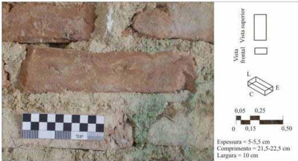
Figura 073. Ficha de identificação do Tijolo T8. Observa-se a cor/ composição de argila vermelho e telha, o formato retangular regular e a face fratura e lisa, com aresta viva. Fonte: Figura pela autora.
