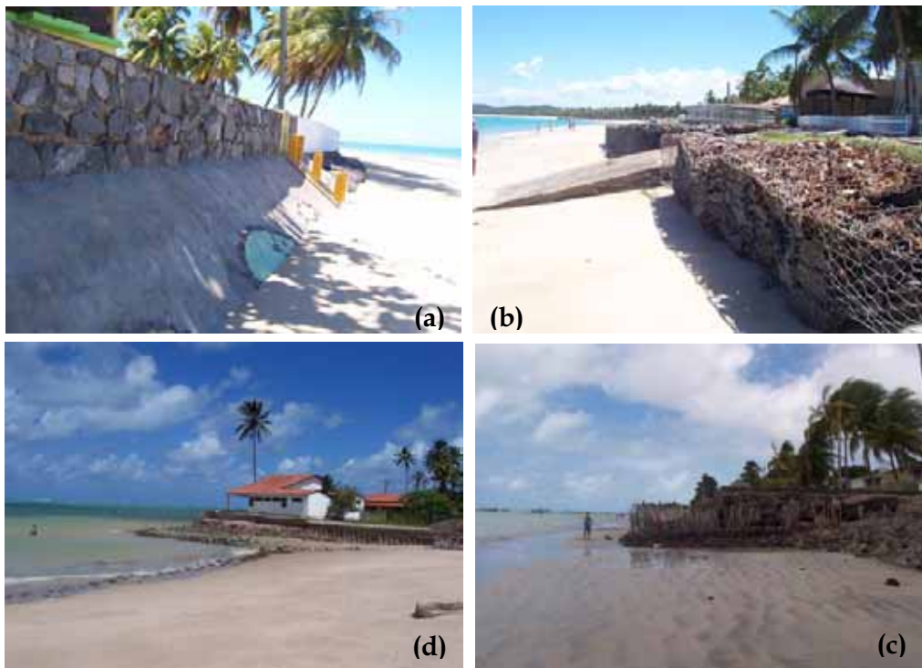
Figuras 57 – Praias com elevado IPVIA (sentido horário): (a) e (b) obras de contenção da erosão (muros e gabiões) na região central de Tamandaré; (c) e (d) edificações avançando o estirâncio e enrocamentos no norte de São José da Coroa Grande.
