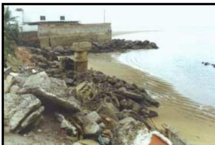
**Figura 3.9.** Restos de construções destruídas pela ressaca no bairro de Barra das Jangadas. Fonte: Assis (2001).
