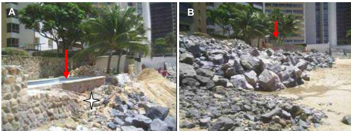
Figura 30. Vista mostrando a destruição do muro do prédio (estrela) com exposição da piscina (seta - A) e perda do RN em Agosto de 2007 indicado pela seta (B) devido à expansão do enrocamento.
