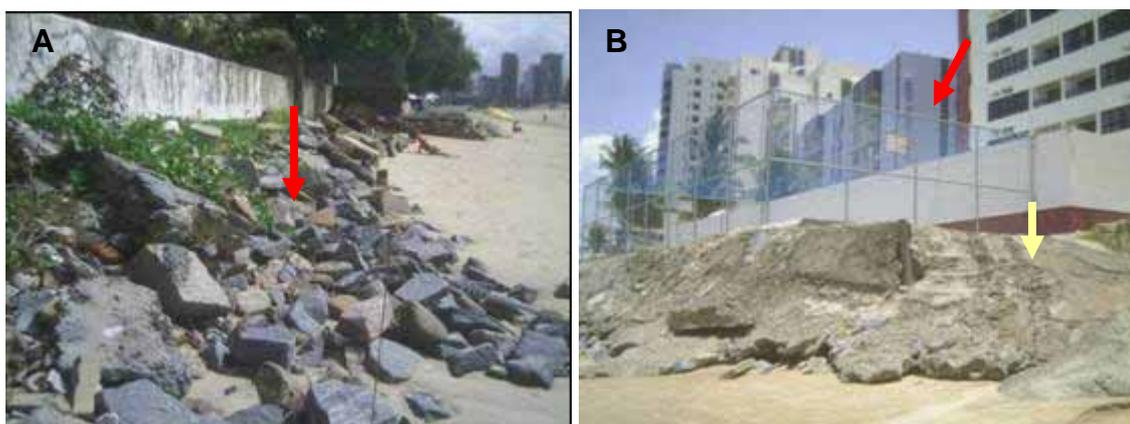
Figura 18. Vista do enrocamento (seta vermelha - foto A). Impermeabilização e aterro (seta amarela) sobre a pós-praia (B) e construção da quadra poliesportiva (seta vermelha - B) em Março de 2007.
