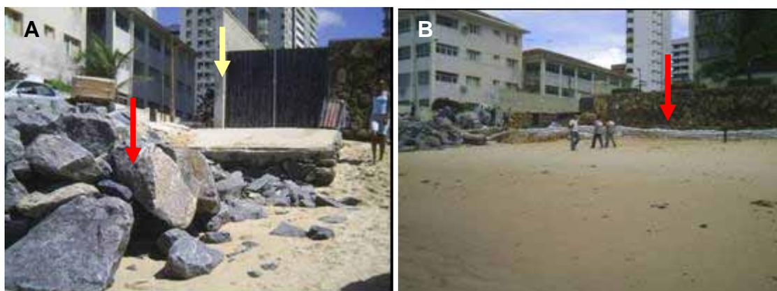
Figura 26. Vista mostrando a interferência do enrocamento (seta vermelha) em Julho de 2006 sobre o RN (seta amarela - A) e a colocação de sacos de areia na base do muro do edifício Ancoradouro no mês de Agosto (seta - B).
