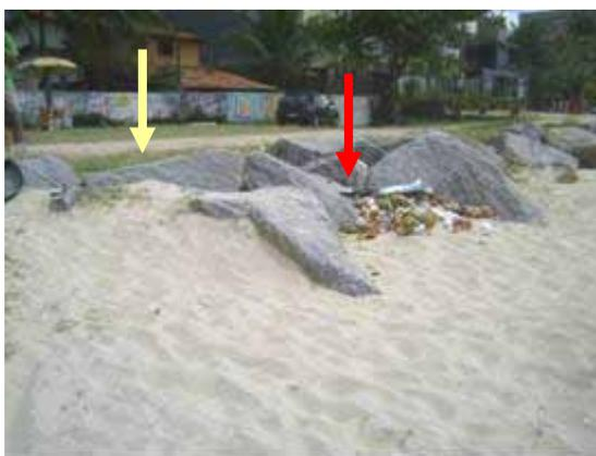
Figura 13. Vista para norte do enrocamento (seta vermelha) e aterro (seta amarela) sobre parte da pós-praia.
