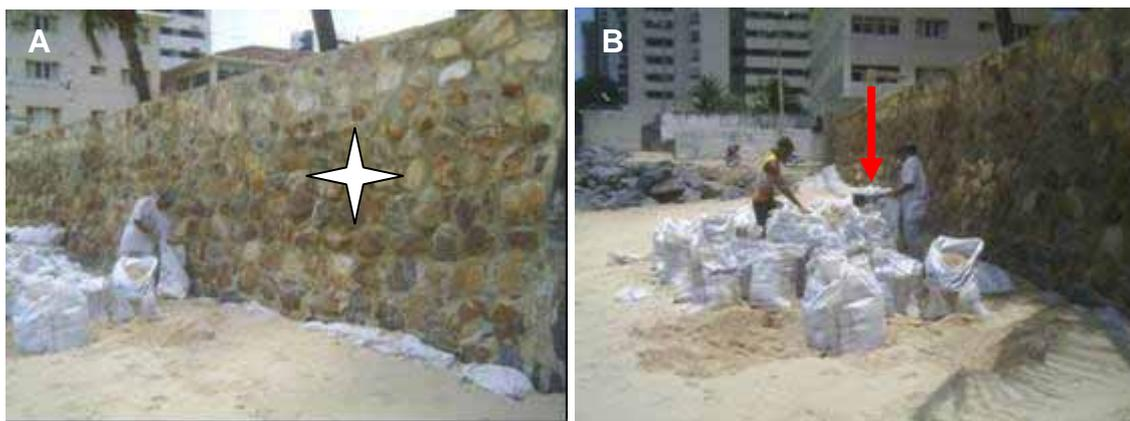
Figura 29. Vista do muro do prédio recuperado em Março de 2006 (estrela) (A) e da colocação de sacos de areia na base do muro do mesmo (seta) (B).
