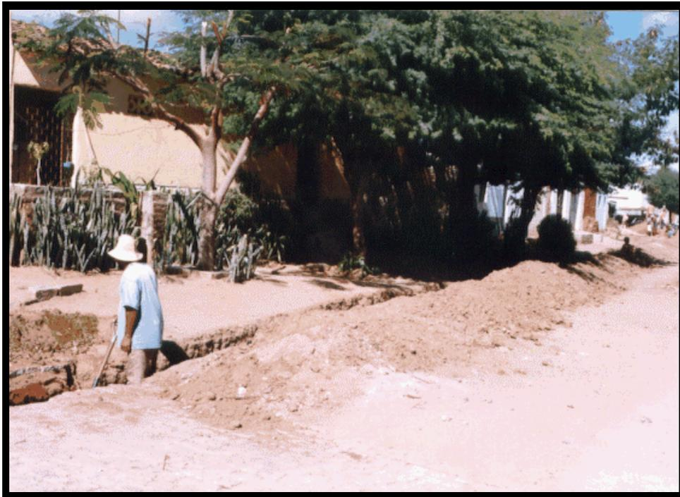
**Foto 4 - Construção de rede de esgoto**
