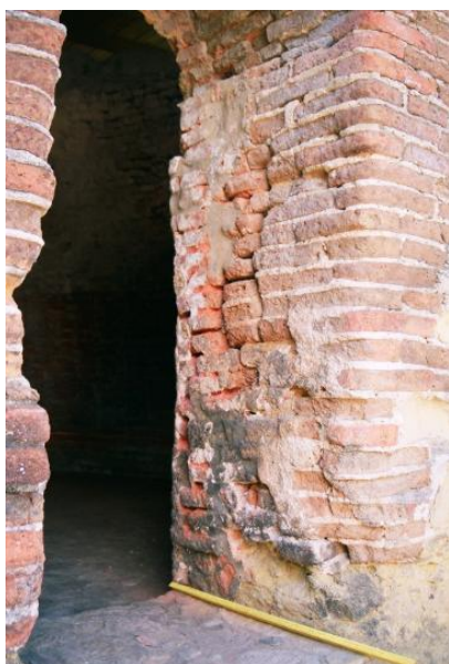
FOTO 21- PAREDE EXTERNA DO FORNO.
