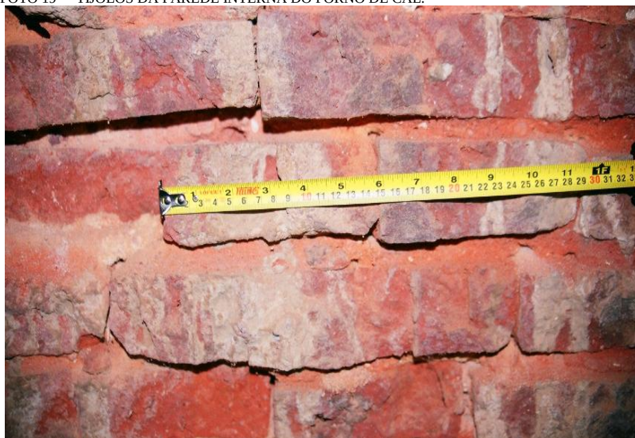
FOTO 19 - TIJOLOS DA PAREDE INTERNA DO FORNO DE CAL.
