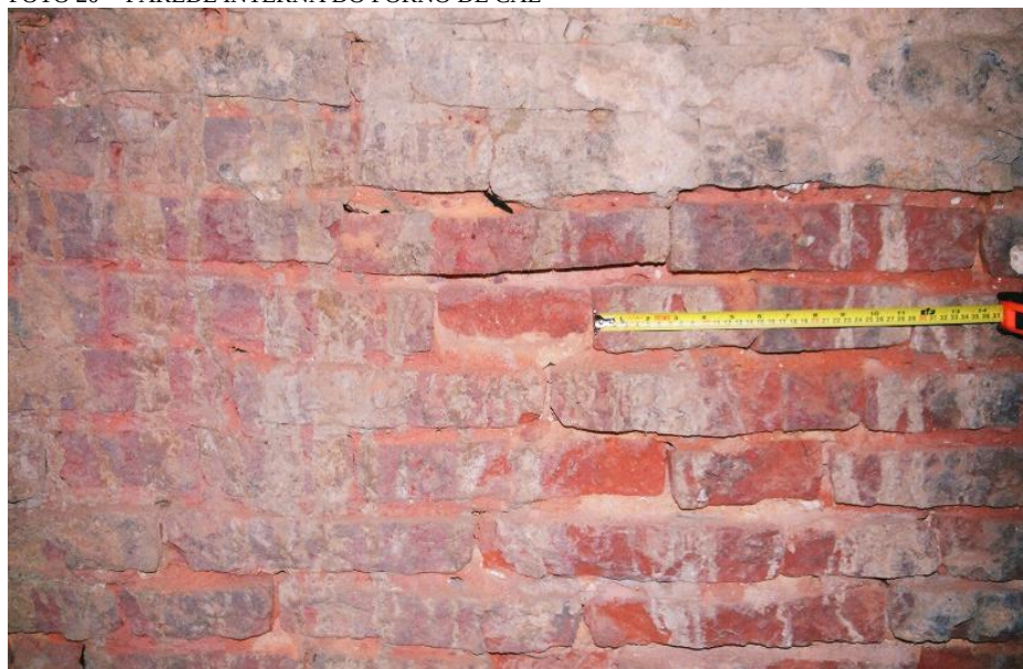
FOTO 20 - PAREDE INTERNA DO FORNO DE CAL
