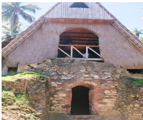
FOTO 15' – FORNO DE CAL + RESIDÊNCIA.
