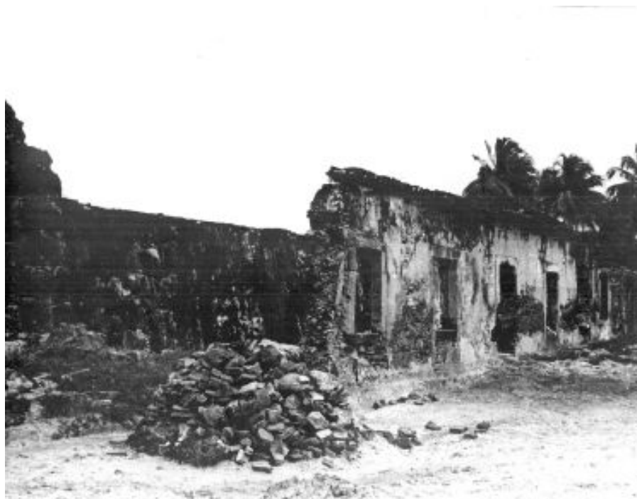
Ilustração 10 – Dependências sul do Forte de Orange em ruínas. Acervo fotográfico do IPHAN – Superintendência Regional em Pernambuco.
