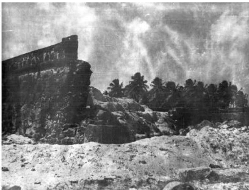
Ilustração 28 – Baluarte do Forte Orange em ruínas. Acervo fotográfico do IPHAN – Superintendência Regional e Pernambuco.
