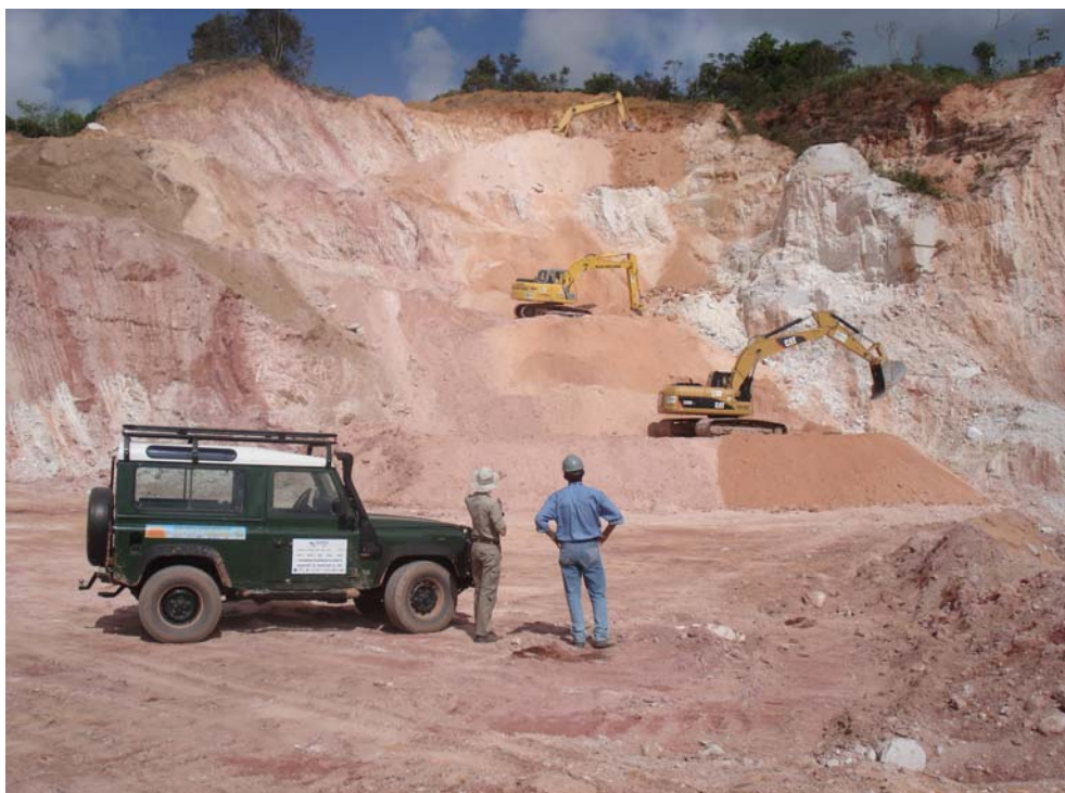
Ilustração 27 – Desmonte de barreira em Palmares-PE durante as obras de duplicação da BR-101 Nordeste, trecho RN-PE. Acervo do Laboratório de Arqueologia da UFPE.
