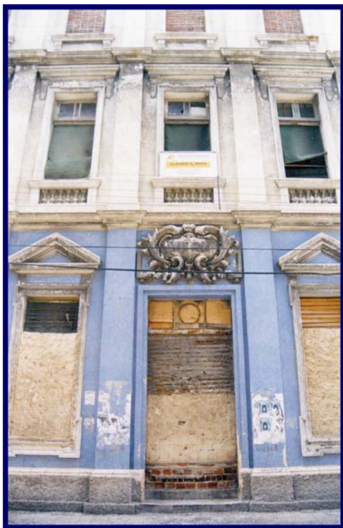
Fig. 28. Fachada do prédio da Via Western. Fonte: Arquivo de Lúcia Falcão Barbosa.
