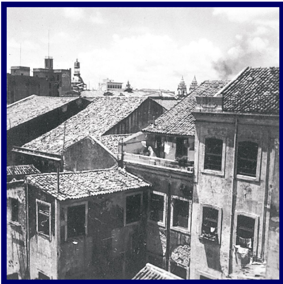
Fig. 30. Antigos telhados do Recife. Fonte: Acervo do Museu da Cidade do Recife.
