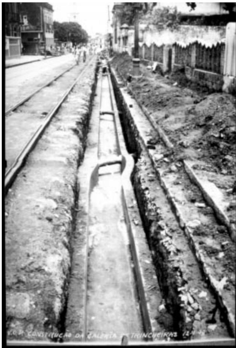
Foto 3 – Instalação do esgoto sanitário no bairro das Trincheiras – 1923
