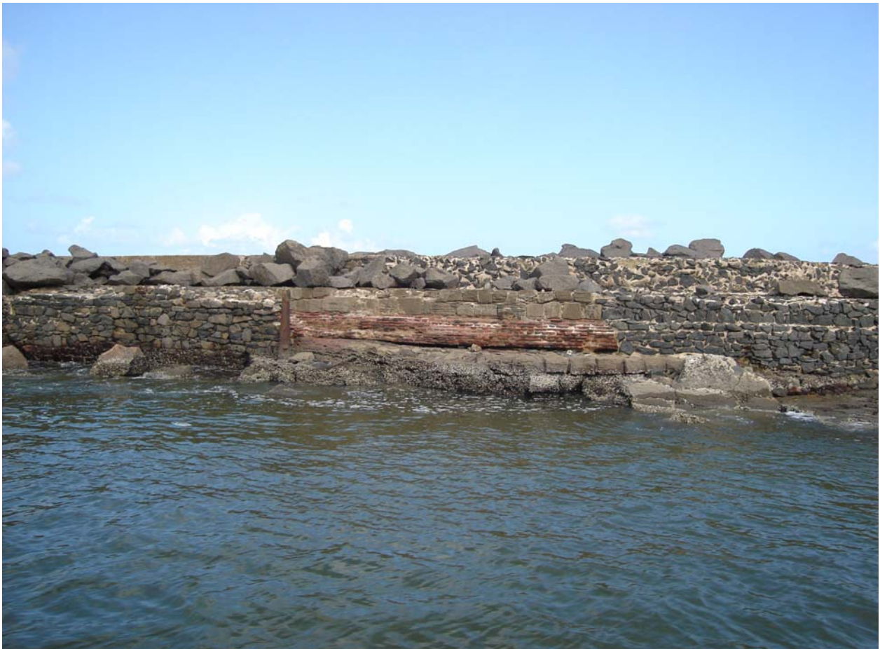
Foto 03: Estratigrafia do molhe: recife de arenito com camadas de blocos calcários, tijolos de barro, paralelepípedos e blocos de granito.
