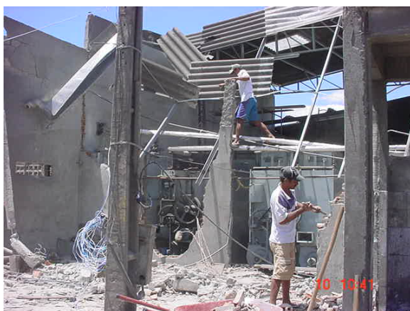
Figuras 30 e 31 – marcas da explosão de uma caldeira – Fonte: Gilson Lima, 2001
