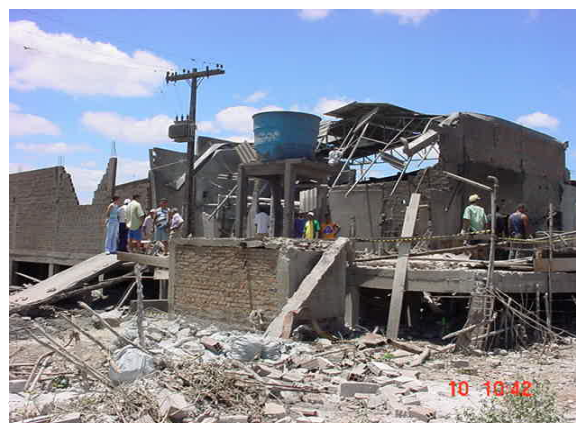
Figuras 30 e 31 – marcas da explosão de uma caldeira – Fonte: Gilson Lima, 2001
