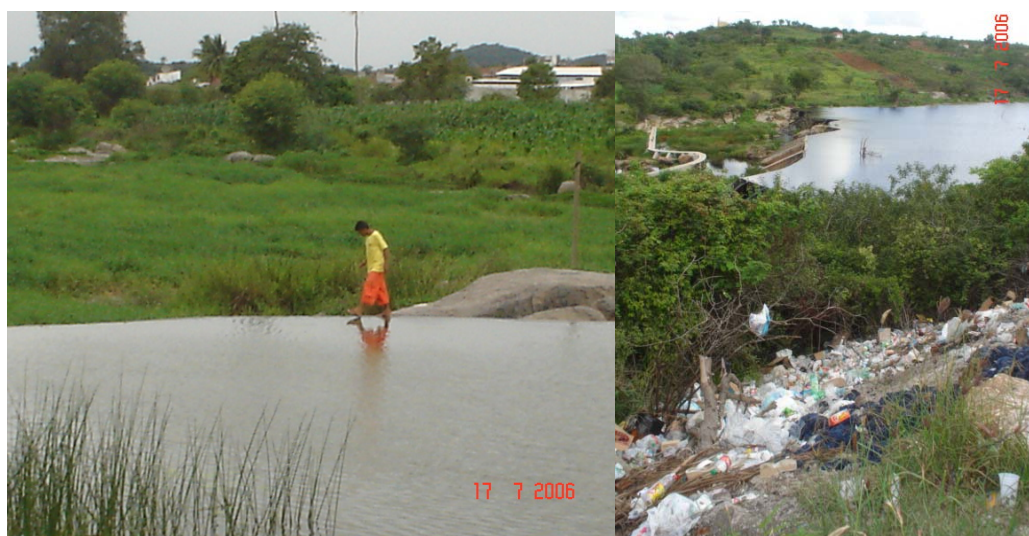
Figura 3: Barramento do rio Capibaribe II - Fonte: Francicleide Palhano, 2006.
