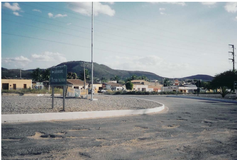
FOTO – 3 Contorno de acesso para PE-270 no município de Arcoverde
