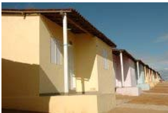
FOTO 28 – Vista parcial das casas da Vila Agrícola do Bem - Buíque
