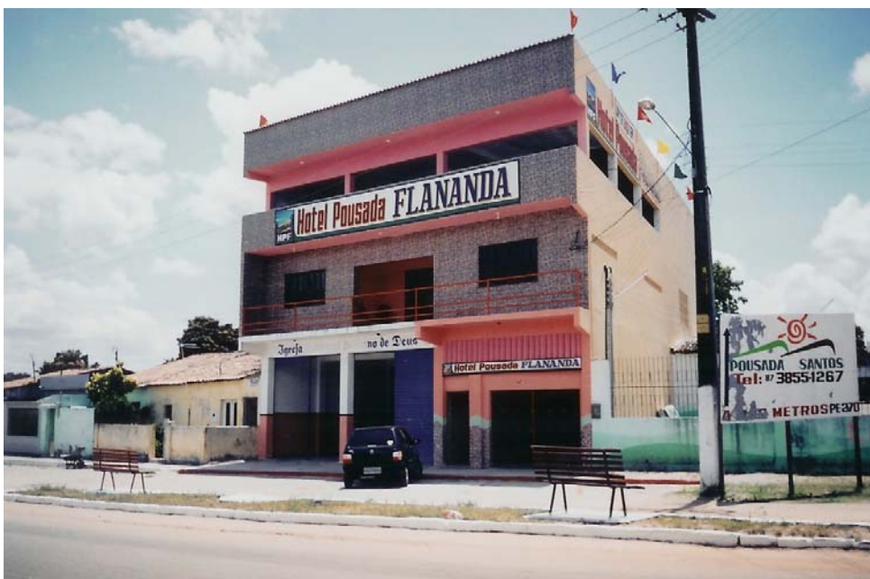
FOTO 21 – Fachada da Pousada Flananda
