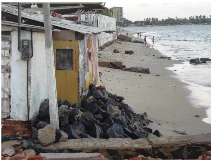
Figura 32 – Utilização dos blocos desprendidos dos gabiões para a proteção de pequenos empreendimentos à beira-mar.
