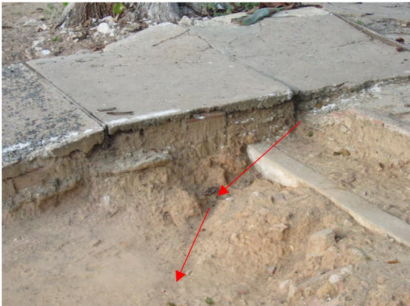
Figura 14 – Erosão Linear Escavando Sulcos em Aterros Realizados às Margens do Maceió.
