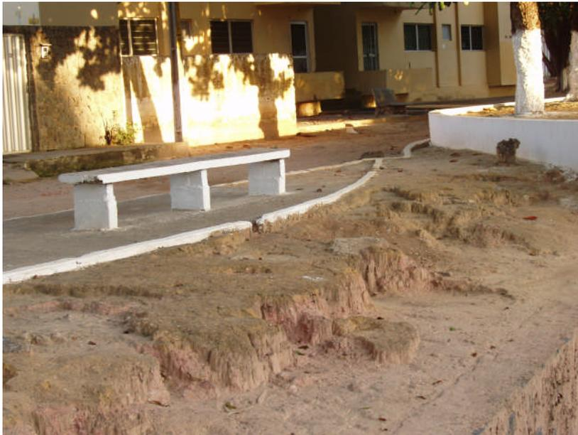
Figura 13 – Erosão Laminar Atuando Ativamente ao Longo dos Aterros não Vegetados Realizados nas Margens do Maceió.
