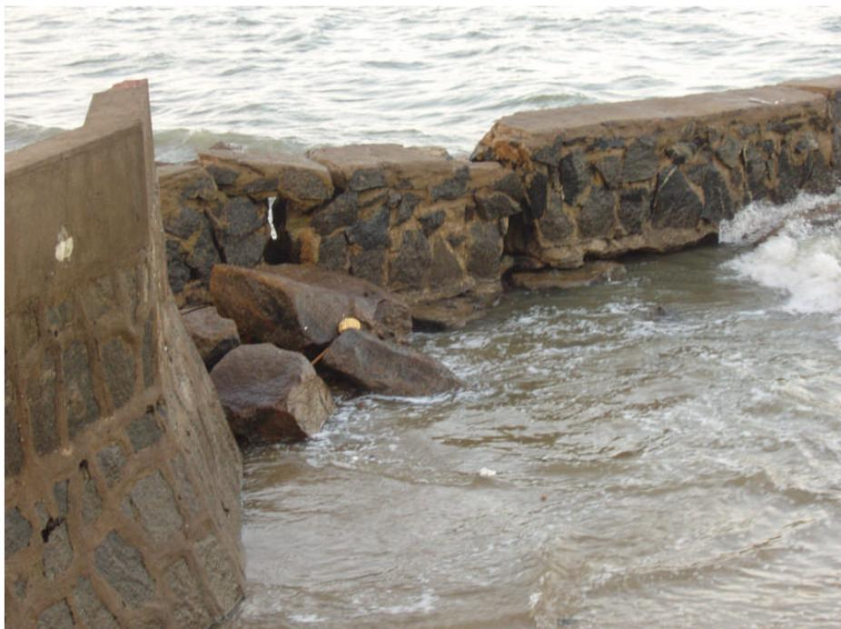
Figura 31 – Destruição dos gabiões de contenção pela erosão marinha na embocadura do maceió nossa sra. Aparecida.
