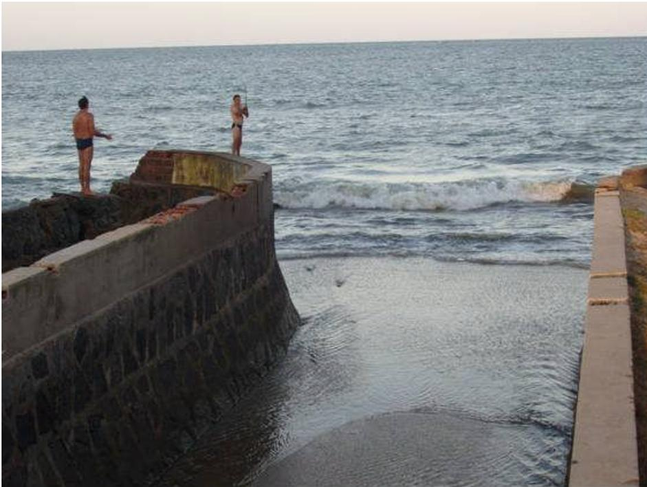
Figura 29 – Aspecto do aporte de sedimentos arenosos de origem marinha a partir da embocadura do maceió nossa senhora aparecida, em decorrência do fluxo das marés.
