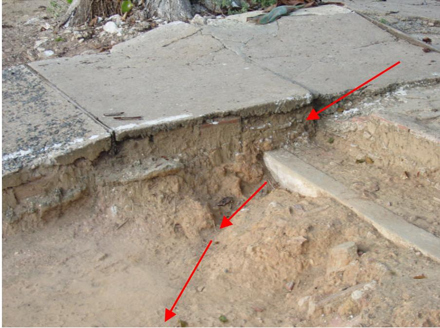
Figura 28 – Detalhe da erosão linear destruindo as estruturas de urbanização da praça Abigail Russel, Janga.
