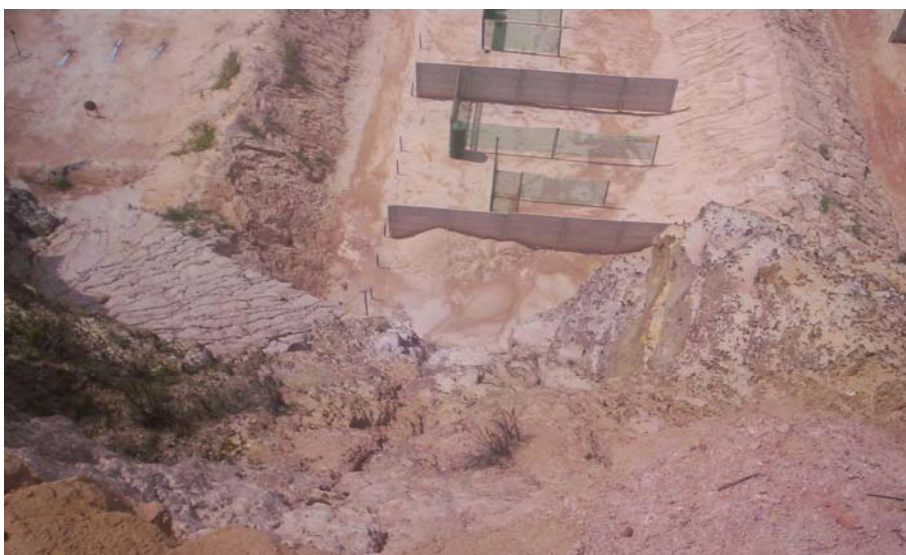
Figura 20 - Encosta apresentando intenso processo erosivo
