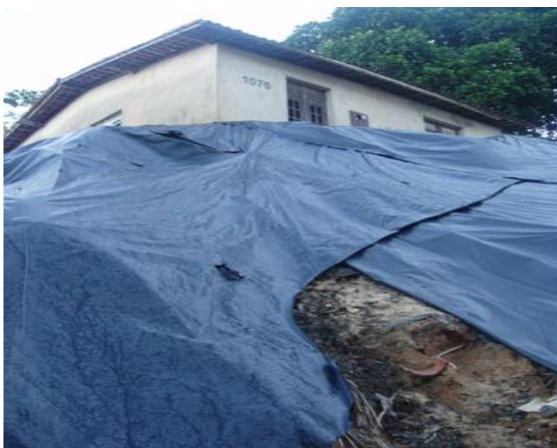
Figura 14 – Proteção da encosta com lona
