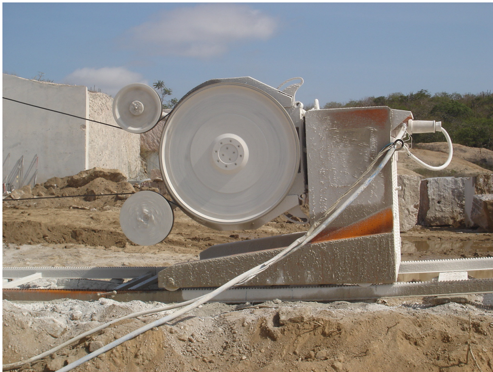
Foto 7 -Máquina de Corte de “Granito” com Fio Diamantado
