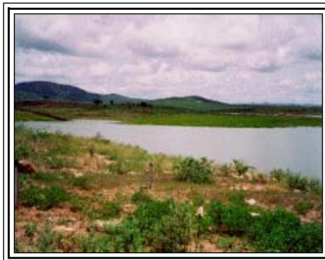
Figura 17 – Açude Custódia - DNOCS
