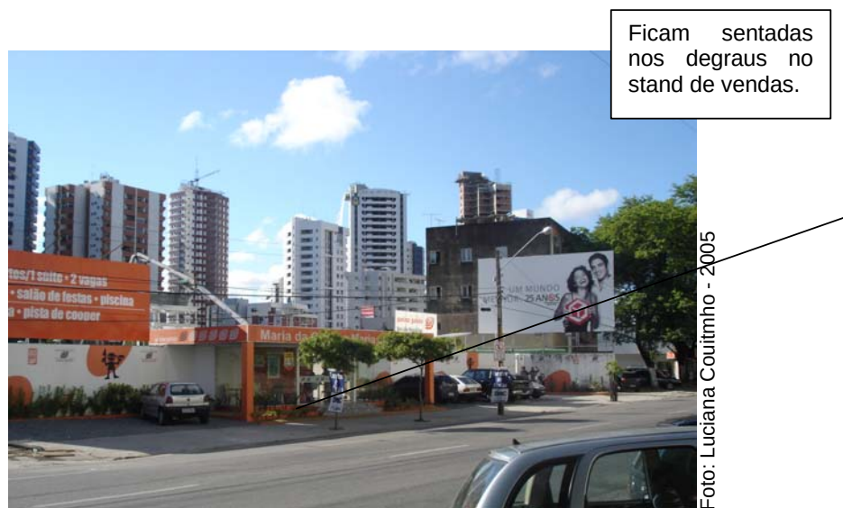
Figura 46 - Empreendimento imobiliário do grupo Queiroz Galvão, em construção, nas proximidades do Edf. Holliday
