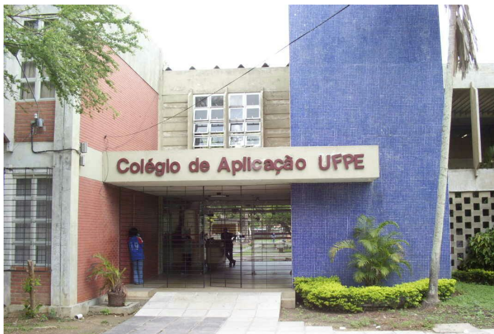
Foto n º 12 vista da entrada do colégio 2004. Wellington Lira
