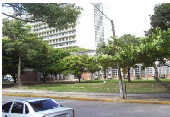
Foto n °25 vista do entorno do colégio 2004.
