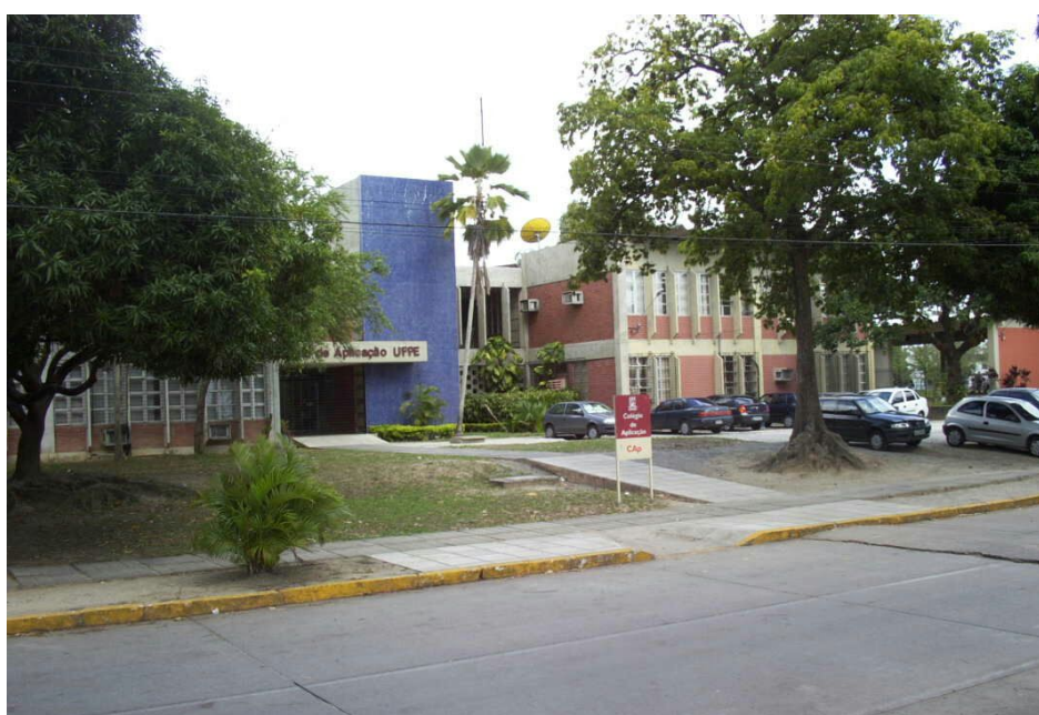
Foto n º 13 vista da entrada do colégio 2004. Wellington Lira
