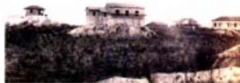
FOTO 24 - Construção de Residências Secundárias Fazenda Nova - 1938 Fonte : Álbum da Família Mendonça
