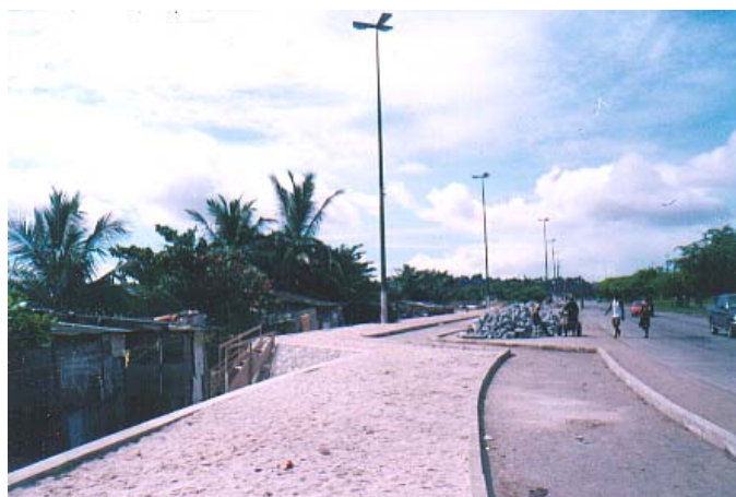
Figura 16 – Obras de reurbanização da orla lagunar
