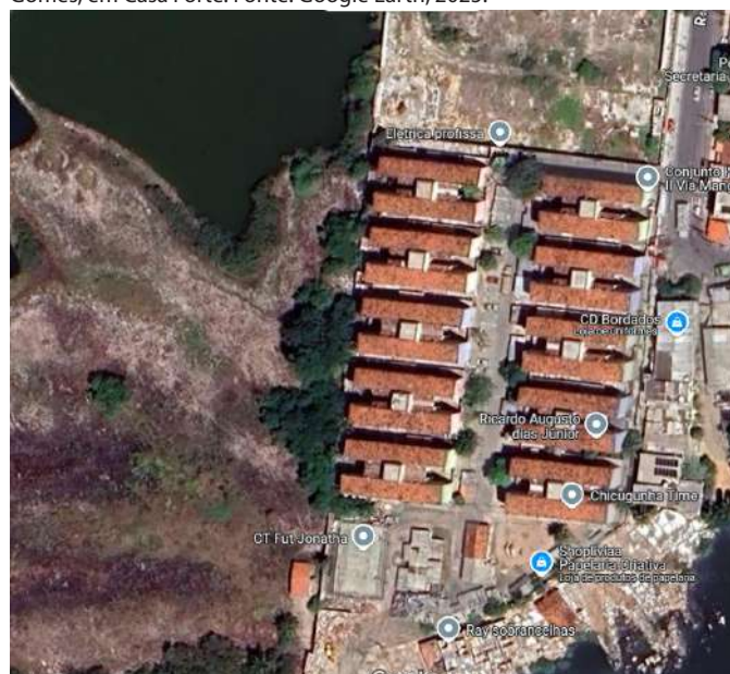
F81| Vista aérea do conjunto habitacional Via Mangue No 11.
