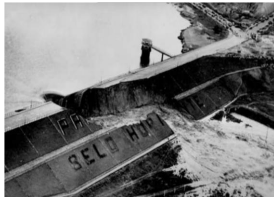
Imagem 20 – Barragem da Pampulha rompida
