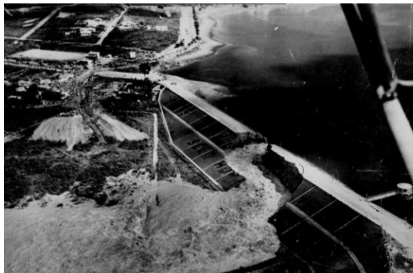
Imagem 19 – Barragem da Pampulha rompida
