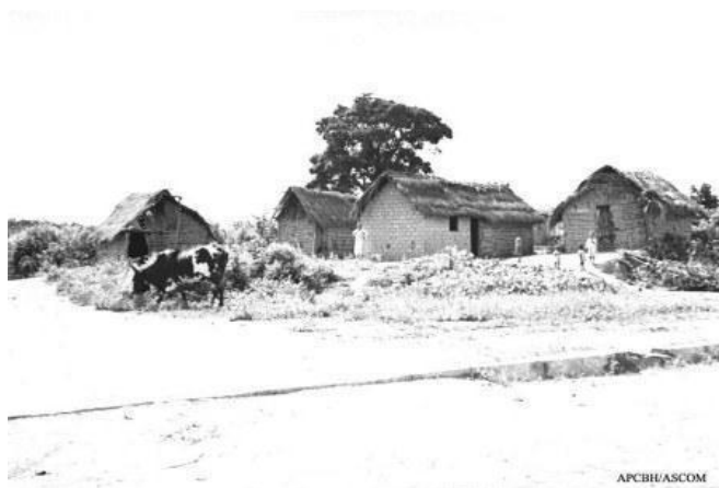
Imagem 03 – Construções em pau a pique e telhado em palha dos antigos moradores da região de Bento Pires
