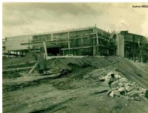
Imagem 11 – Obras de construção do Cassino da Pampulha, 1945
