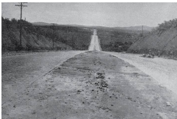
Imagem 05 – Avenida Pampulha, 1941 (atual Av. Antônio Carlos, sentido centro – Pampulha)
