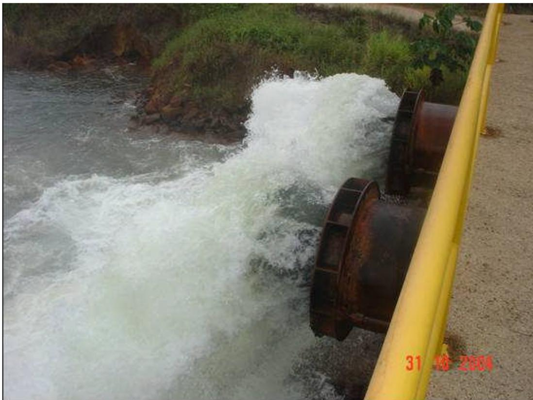
Figura 1.3. Descarregadores de funda da Barragem do Pirapama
