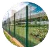
**Gradil Metálico:** Adotado para o cercamento do parque devido a leveza e permeabilidade visual que ela proporciona ao projeto, além de sua facilidade de instalação e manutenção.
