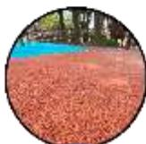
**Piso Fulget:** Adotado para a academia da 3ª idade, é um piso antiderrapante, com uma boa absorção de calor e alta capacidade de drenagem, sendo assim, ideal para áreas abertas.
