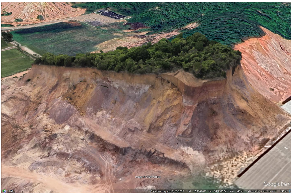
Figura 56: Encosta parcialmente retaludada com escorregamentos translacionais apresentando superfícies de ruptura superficiais de face. Ao fundo, centro de treinamento do Náutico com deslizamento rotacional previamente descrito. Fonte: Google Earth, 2025.
