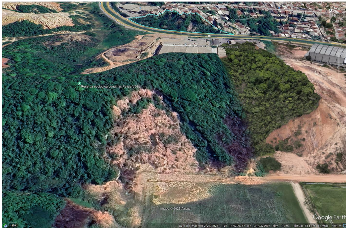
Figura 55: Escorregamento rotacional em encosta natural com superfície de ruptura de base atingindo o campo de futebol. Ao fundo, talude do Alto da Telha (em azul). Fonte: Google Earth, 2025.
