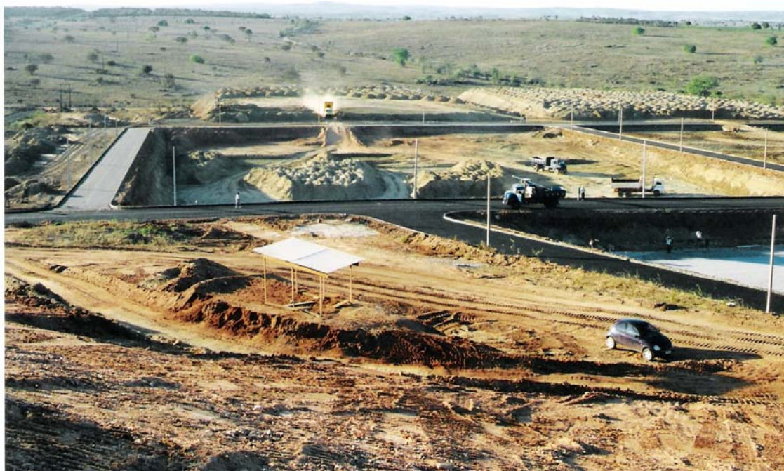
Foto 1: Construção de aterro sanitário no município de Garanhuns
