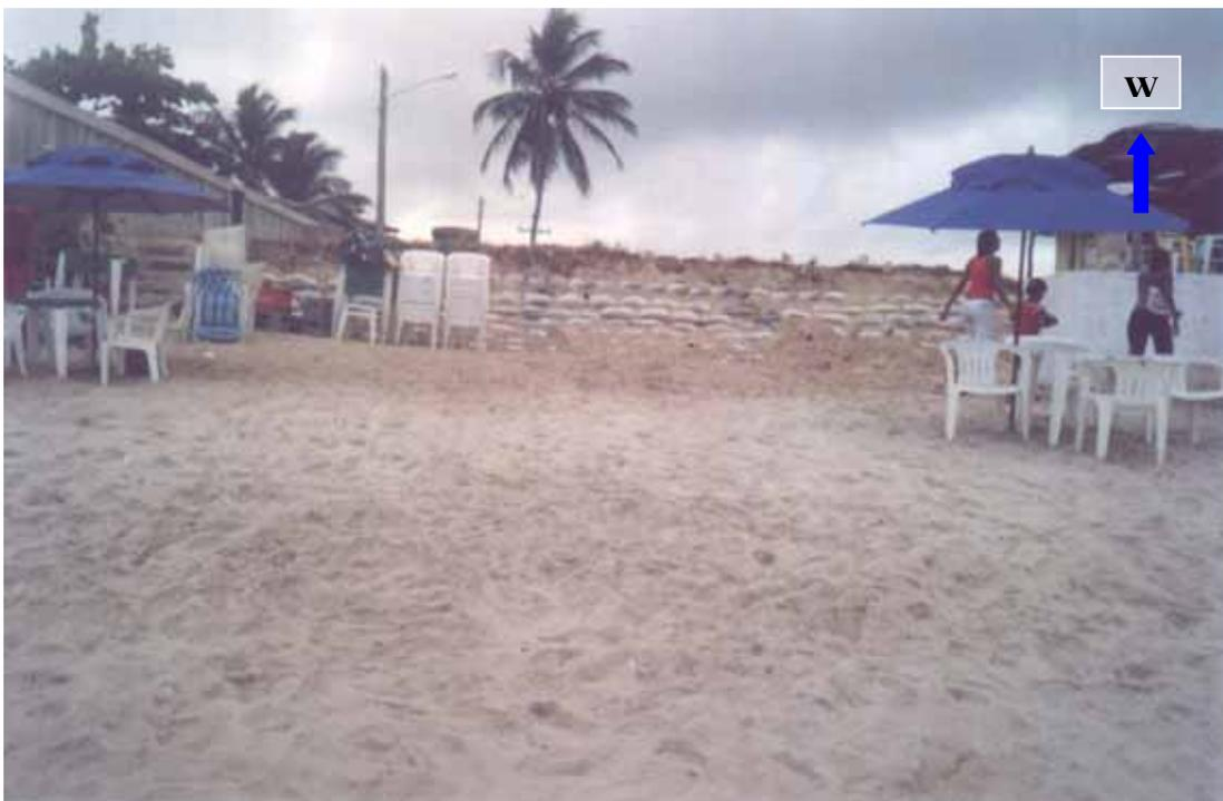
Foto 7.18 - Sacos plásticos preenchidos com areia, na escarpa de berma, visando amenizar o processo erosivo já instalado.
