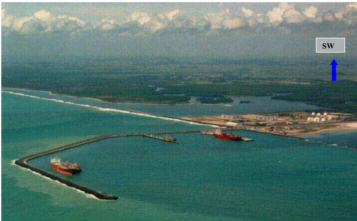
Foto 9.10 – Vista do porto de Suape, cujas obras alteraram a hidrodinâmica, morfodinâmica e morfologia da área a Sul do Cabo de Santo Agostinho (Foto – Suape, Complexo Industrial Portuário, 1999).
