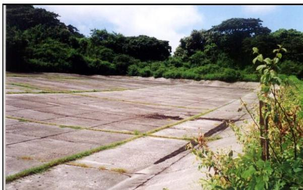
**Figura 6: Placa de captação de água pluvial**
