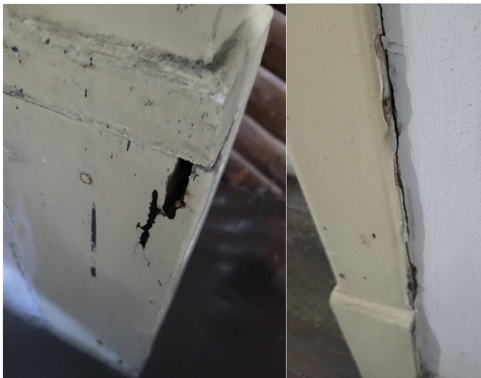
Figuras 39 e 40 – Detalhe de área sem a peça de madeira em função da perda de integridade da parede ou com fissuras na parede
