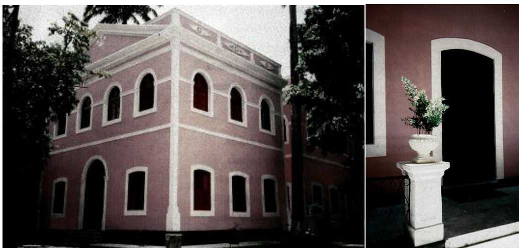
Figura 34 – Fachada externa, calçada e detalhes ornamentais restaurados
