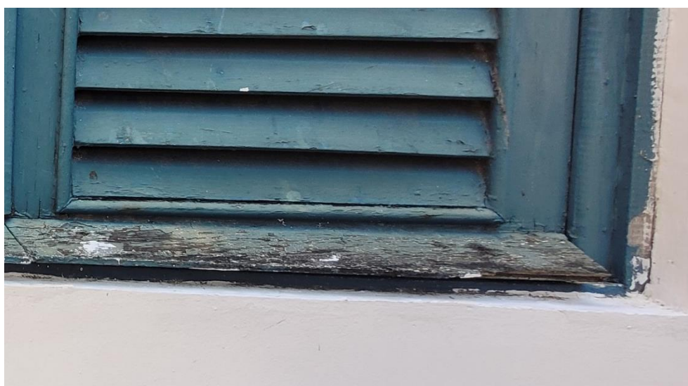
Figura 41 – Degradação do lado externo da veneziana, no piso térreo
