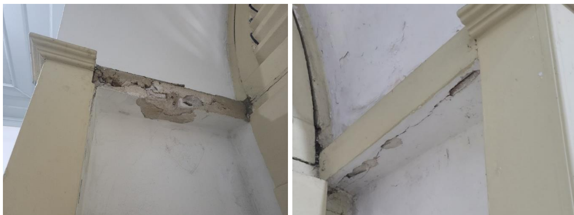
Figuras 39 e 40 – Detalhe de área sem a peça de madeira em função da perda de integridade da parede ou com fissuras na parede
