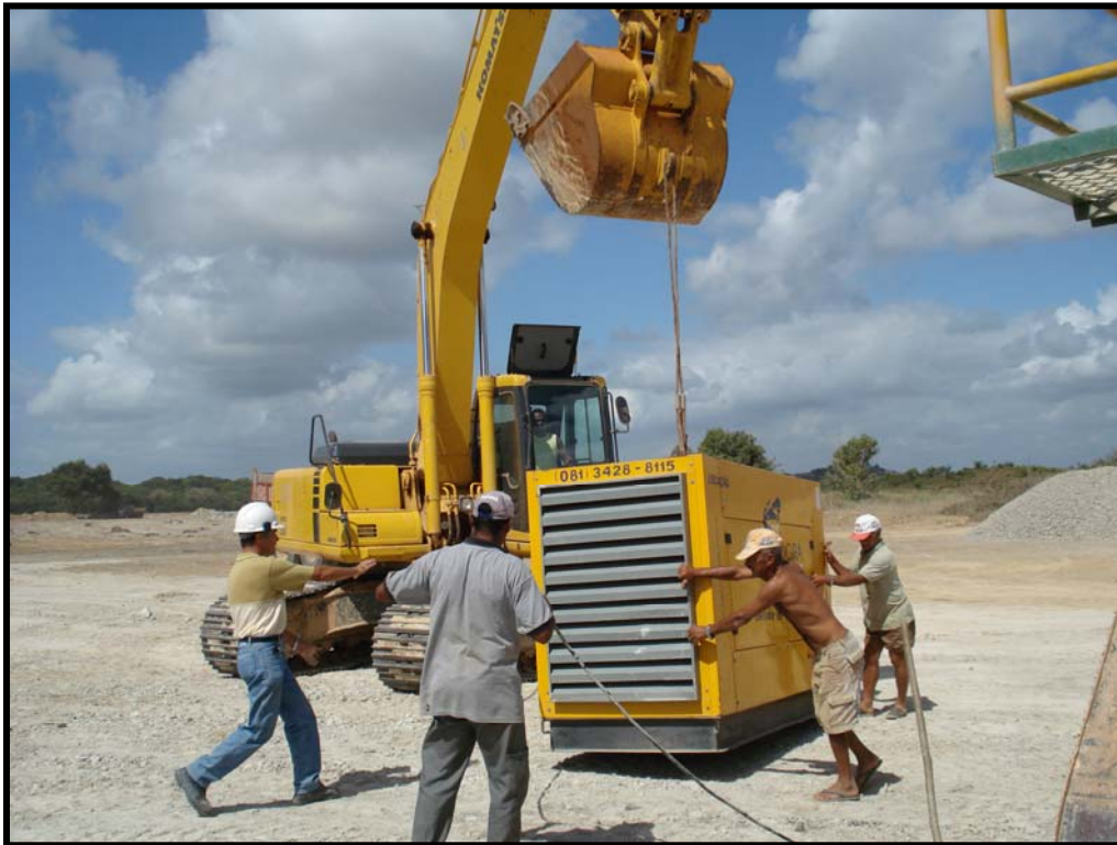
Figura 04 - Instalação de máquina geradora de energia, Cabo de Santo Agostinho-PE
