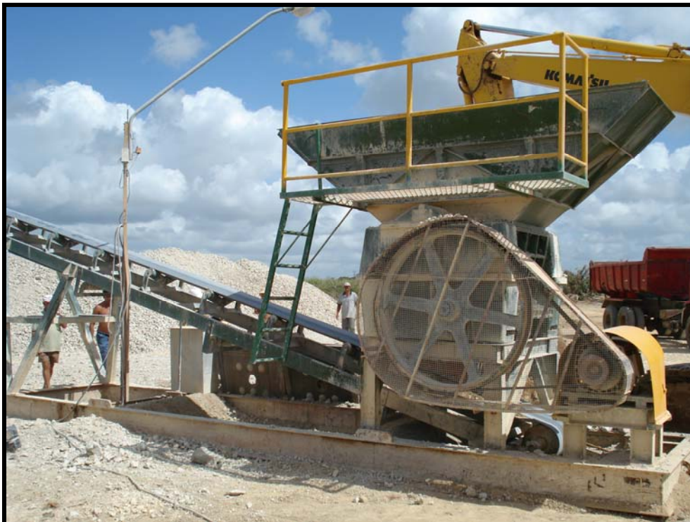
Figura 05 - Instalação de máquina destorradeira, Cabo de Santo Agostinho-PE Fonte: Gabriela Monteiro Cabral, novembro 2006
