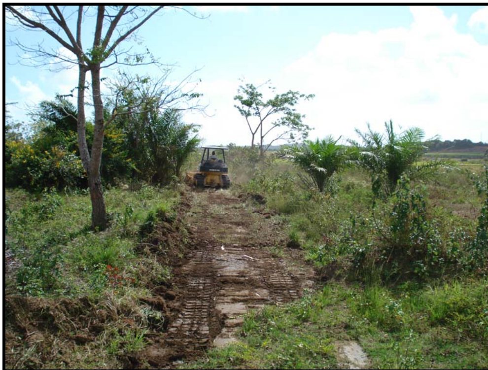
Figura 03 - Abertura de estrada para dar acesso ao local de extração, Cabo de Santo Agostinho-PE Fonte: Gabriela Monteiro Cabral, novembro 2006.
