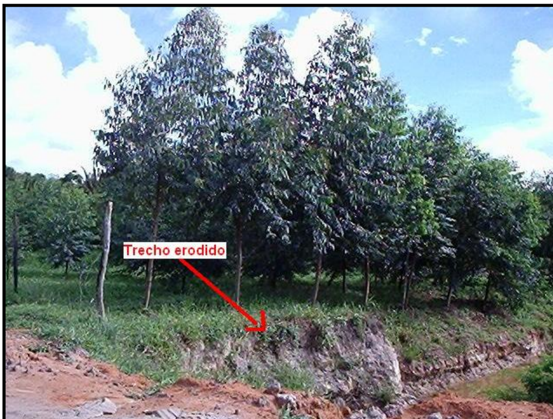
Figura 15 – Foto trecho erodido, Cabo de Santo Agostinho-PE Fonte: Gabriela Monteiro Cabral, novembro 2006.
