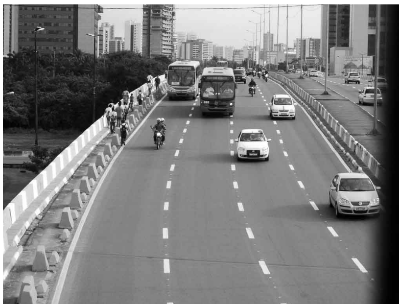
Figura 18 - Viaduto João Paulo II, entre a Av. Agamenon Magalhães e o bairro de Joana Bezerra
