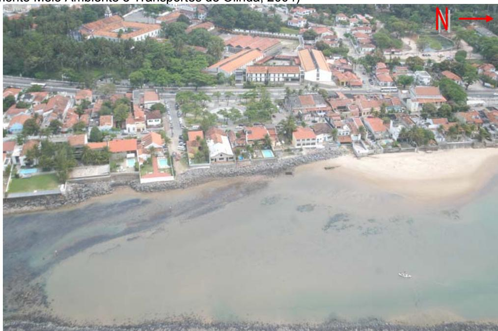
Foto 6.6 – Aspecto geral das obras de contenção do mar construídas entre a Praia dos Milagres e a Praia do Carmo, onde o patrimônio construído já foi bastante afetado; nota-se no canto direito da foto uma deposição de sedimentos arenosos, refletindo a complexa hidrodinâmica local. (Fonte: Diretoria de Meio Ambiente, Secretaria de Planejamento Meio Ambiente e Transportes de Olinda, 2004)
