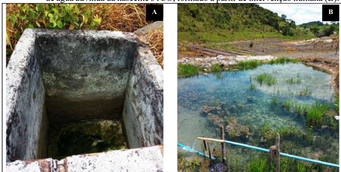
Figura 48- Estrutura de concreto em torno do afloramento da nascente 31CO (A), acúmulo de água advinda da nascente 31CO, formado a partir de intervenção humana (B).
