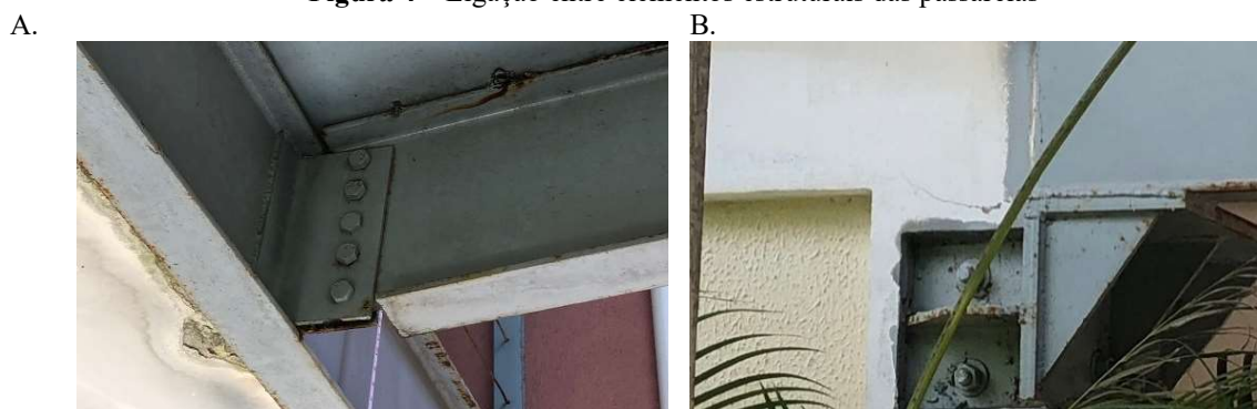
Figura 4 – Ligação entre elementos estruturais das passarelas
