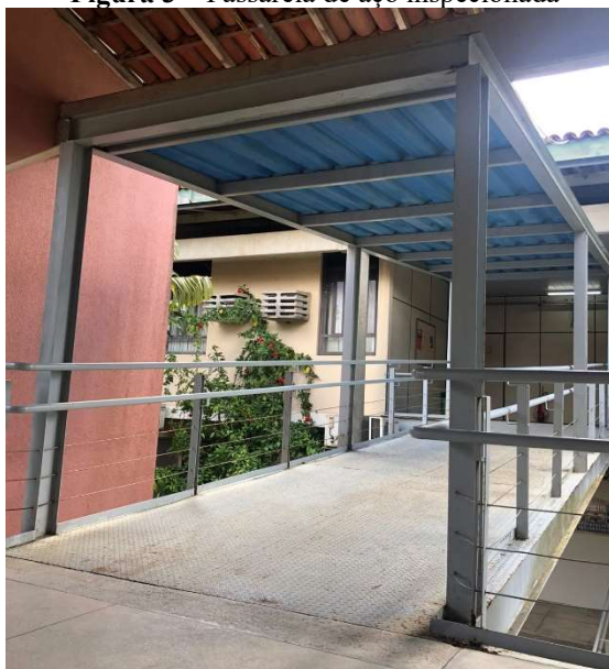
Figura 3 – Passarela de aço inspecionada
