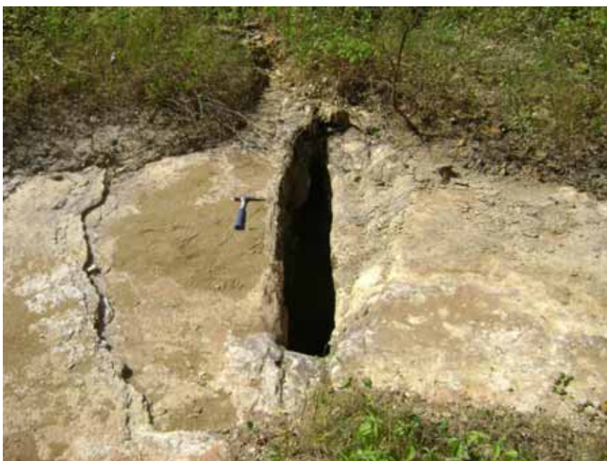
Foto 3.17 – Fissura alargada pela movimentação da água gerando sumidouro na Formação Jandaíra. Estrutura alinhada 310 Az. (ANA-40:654676,9429858)
