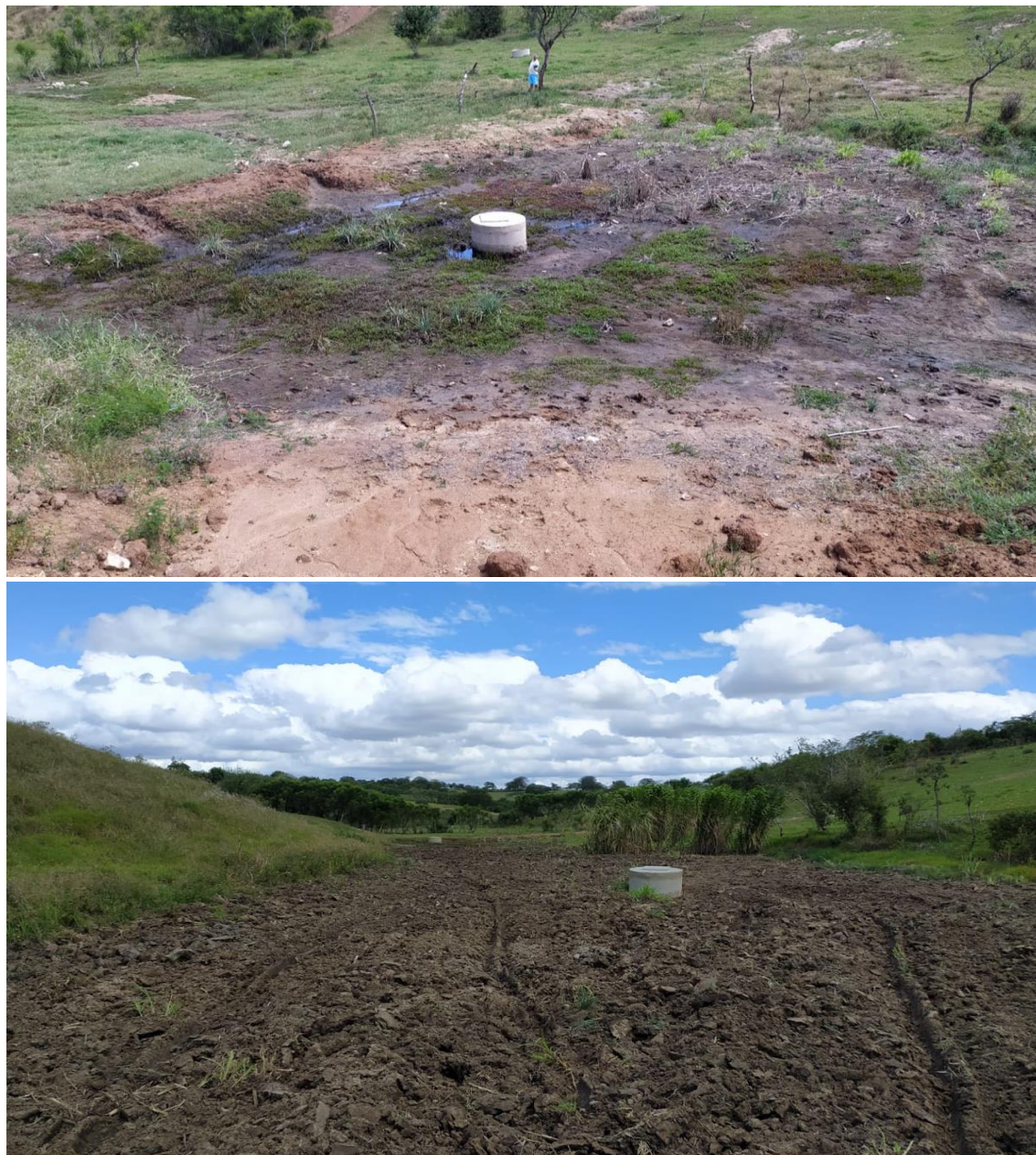
Figura 6 - a) Poço amazonas escavado rente ao barramento; b) Poço amazonas escavado cerca de 50 metros do barramento.
