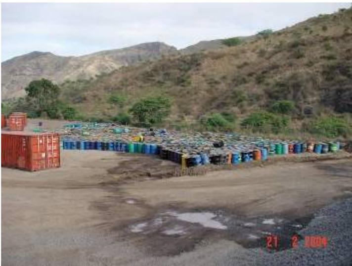
**Figura 39.** Plataforma dos estaleiros sem impermeabilização na zona de Cerrado. **Fonte:** Autora, 2004
