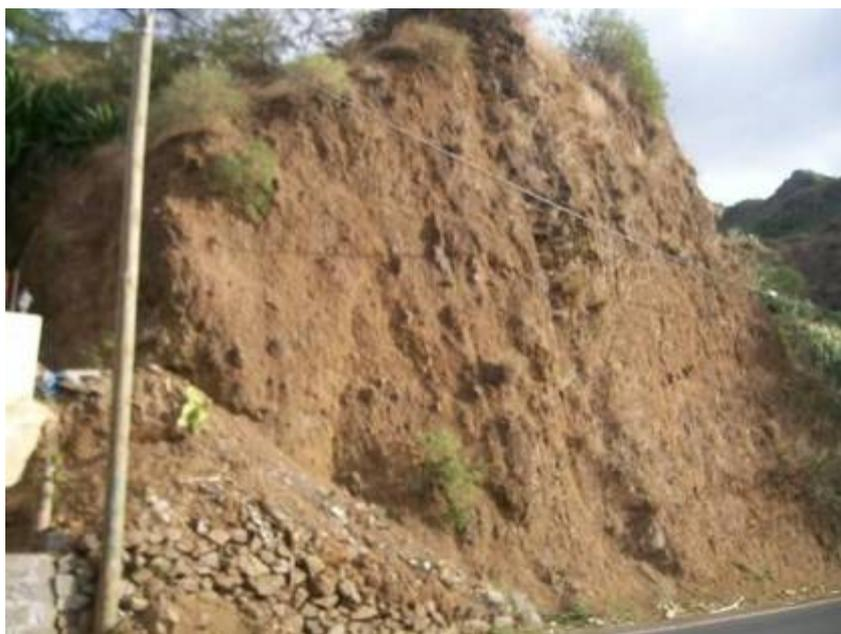
**Figura 73.** Escorregamento de solos (*earth-flow*) com textura pouco coesa na zona dos Picos. **Fonte:** Autora, 2009
