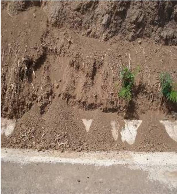
**Figura 24.** Deslizamento de terra para dentro da via na zona de Godim. **Fonte:** Autora, 2008
