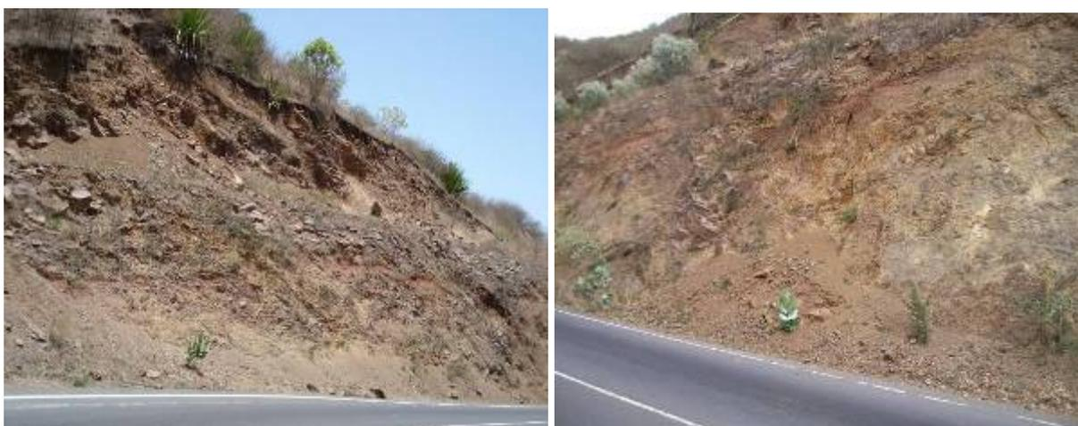
**Figuras 84 e 85.** Técnicas de contenção de erosão pouco eficazes no trecho 1. **Fonte:** Autora, 2009
