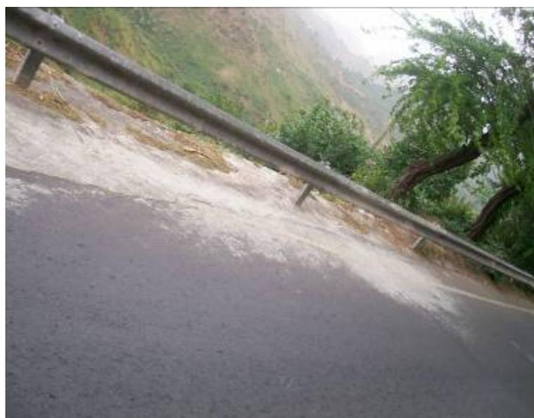
**Figura 57.** Inexistência de valas que levam o escoamento da água para os fundos dos vales. **Fonte:** Autora, 2009
