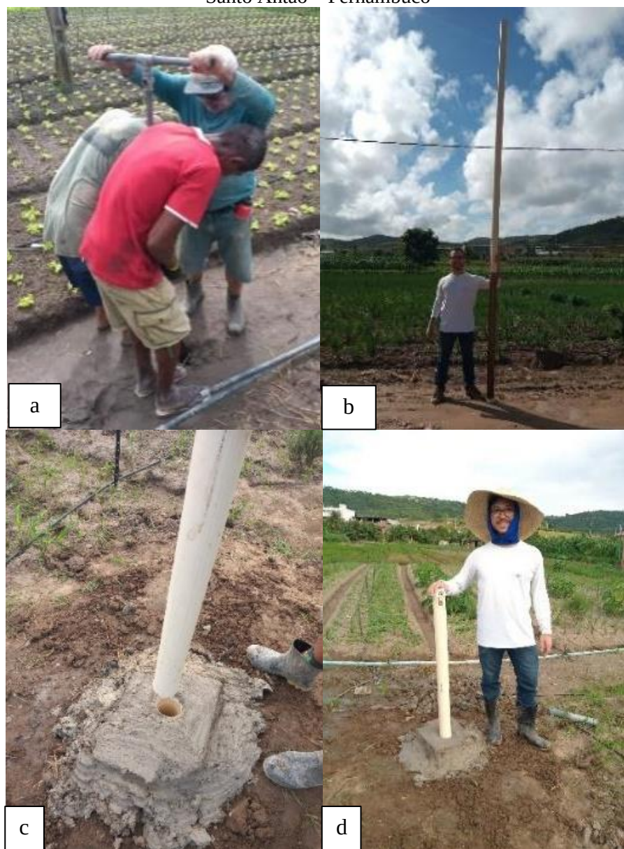
Figura 13 – Processo de instalação dos novos poços de monitoramento no baixo rio Natuba, Vitória de Santo Antão – Pernambuco
