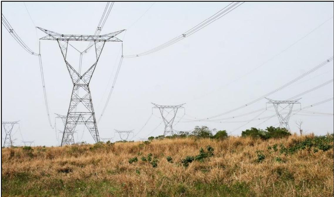
**Figura 1:** Estruturas de rede elétrica inseridas em uma faixa de domínio da BR 232, proximidades do município de Tacaimbó-Pe. A vegetação em regeneração em primeiro plano foi retirada para evitar que o seu crescimento e posteriores incêndios provoquem circuitos e interfiram na distribuição de energia. (Foto: Natalício Rodrigues, 2008).
