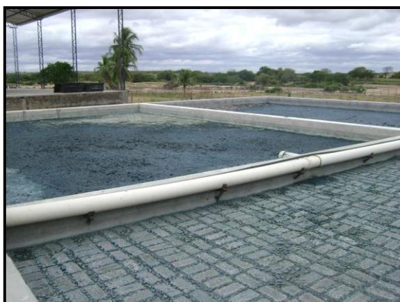
**Foto 31:** Jardim de Piranhas: área de secagem da estação de tratamento de efluentes da Monkey Têxtil S.A, com destaque para os resíduos.
